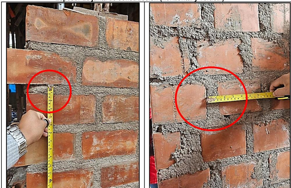
Se aprecia muros de ladrillo de ambientes del primer nivel de los módulos 1 y 3 del proyecto, presentan un espesor de juntas de construcción (verticales y horizontales) de hasta 3.00 cm.
