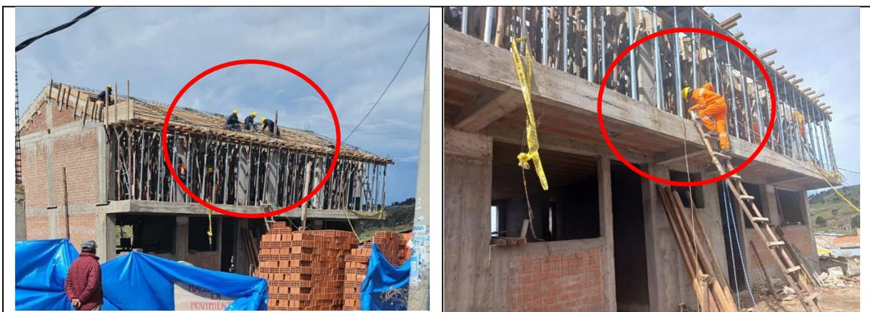
Se aprecia a personal obrero ejecutando trabajos de en altura ((encofrado de losa inclinada de segundo nivel de módulo 1), sin contar con arnés ni línea de vida.
