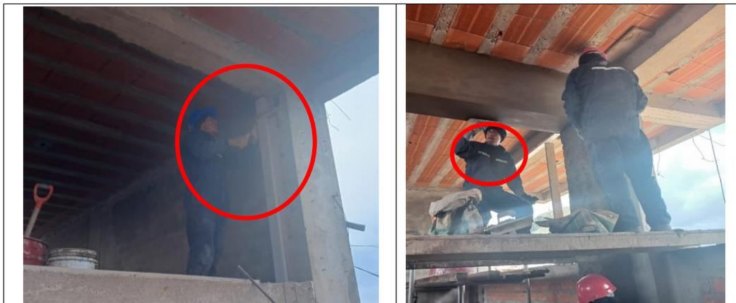
Se aprecia a personal obrero ejecutando trabajos de tarrajeo de elementos estructurales, sin el uso de guantes y lentes de seguridad
