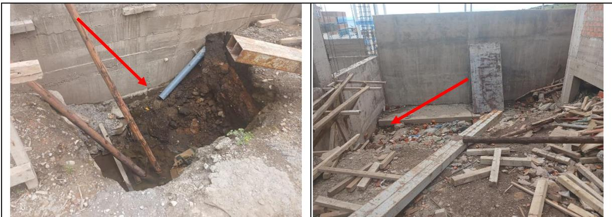
Se aprecia trabajos de excavación sin señalización y cintas de seguridad.
