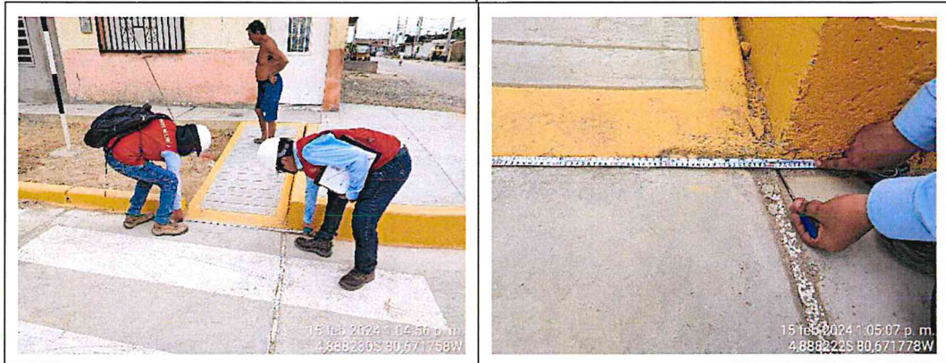
Vistas Fotográficas n.º 18 Ancho de rampa de concreto
