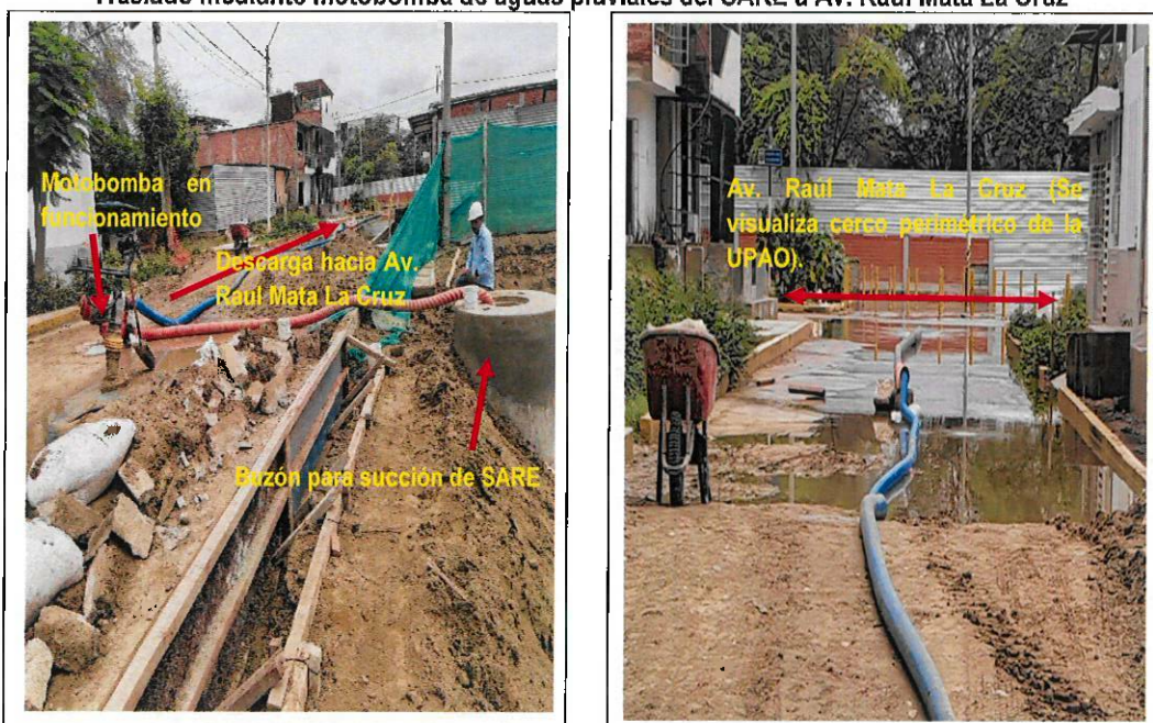
Vistas Fotográficas n.º 3 Traslado mediante motobomba de aguas pluviales del SARE a Av. Raúl Mata La Cruz
