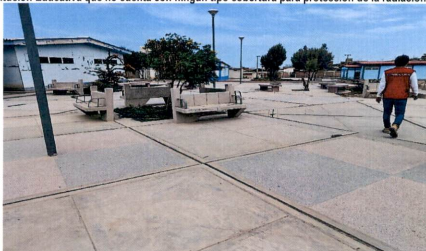
Toma Fotográfica n.º 24 Institución Educativa que no cuenta con ningún tipo cobertura para protección de la radiación solar
