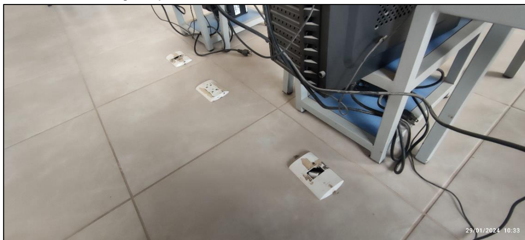
Imagen n.º 34 Algunos puntos o salidas de data se encuentran averiados
