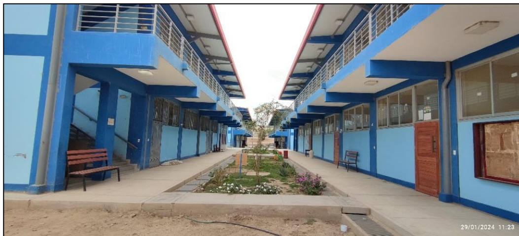
Imagen n.º 60 Ambientes educativos fueron proyectados con barandas metálicas como medida de protección para la circulación de los alumnos.
