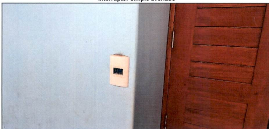
Toma Fotográfica n.º 17 Interruptor simple averiado
