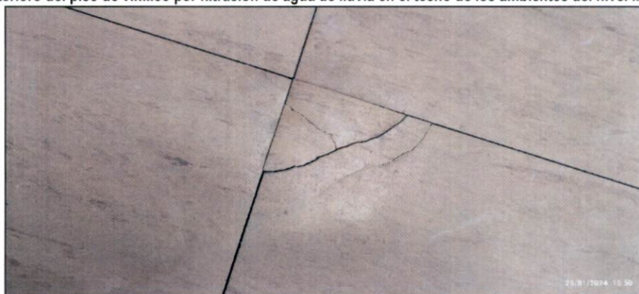
Toma Fotográfica n.º 53 Deterioro del piso de vinílico por filtración de agua de lluvia en el techo de los ambientes del nivel inicial
