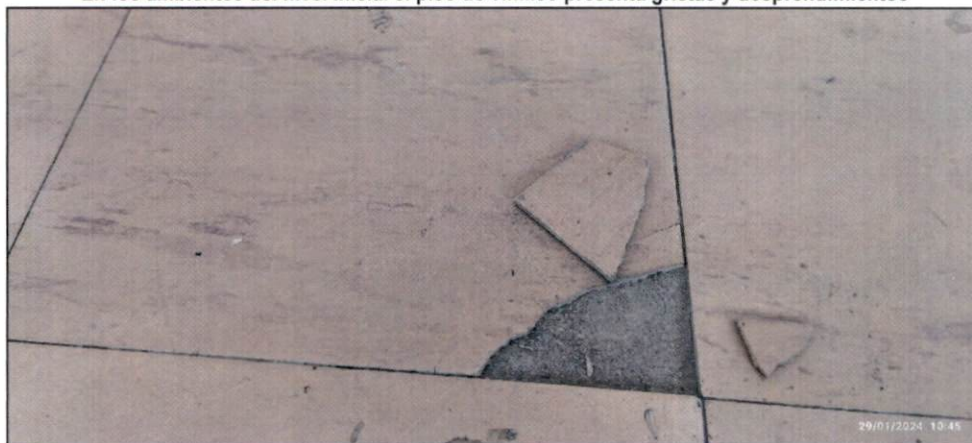
Toma Fotográfica n.º 50 Deterioro del piso de vinílico en ambientes del nivel inicial
