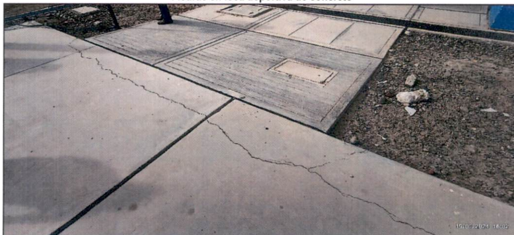
Toma Fotográfica n.º 44 Fisuras en losa deportiva de concreto
