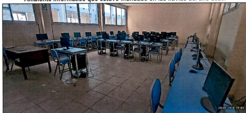
Toma Fotográfica n.º 5 Ambiente informático que estuvo inundado en las lluvias del año 2023.
