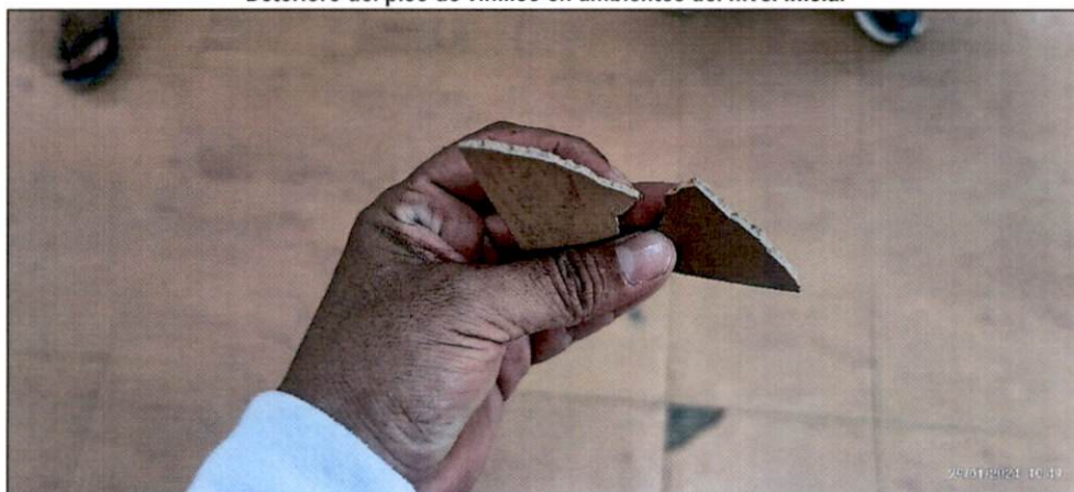
Toma Fotográfica n.º 53 Deterioro del piso de vinílico por filtración de agua de lluvia en el techo de los ambientes del nivel inicial
