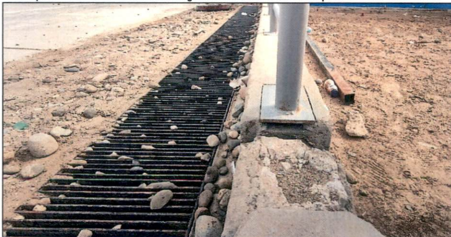
Toma Fotográfica n.º 47 Desprendimiento de barandas de seguridad en ambientes correspondientes al nivel inicial
