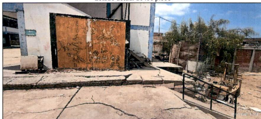
Toma Fotográfica n.º 27 Estado actual de los pisos
