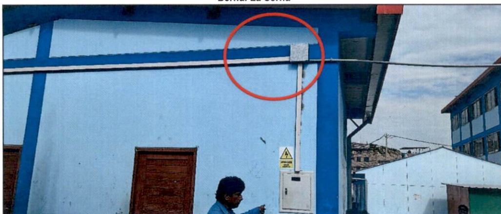
Toma Fotográfica n.º 26 Conexión del sistema eléctrico del plan de contingencia al sistema eléctrico de la Institución Educativa Eliseo Alcides Bernal La Serna
