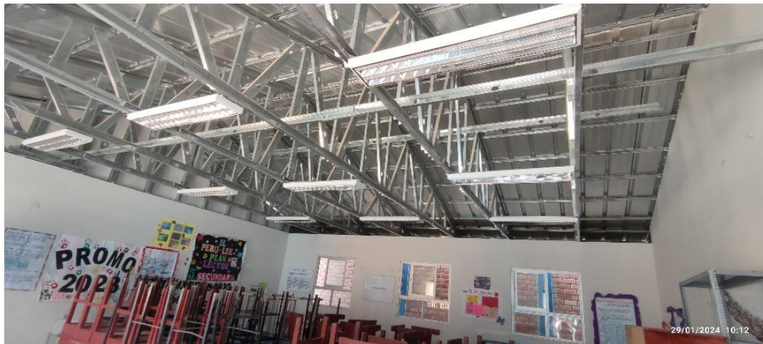
Imagen n.º 25 Sistema de alumbrado con fluorescente en las aulas del plan de contingencia, se desconoce la máxima demanda
