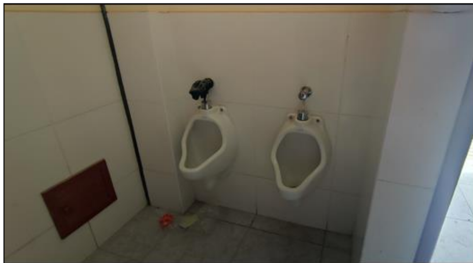
Imagen n.º 37 Los urinarios tipo fluxómetros
