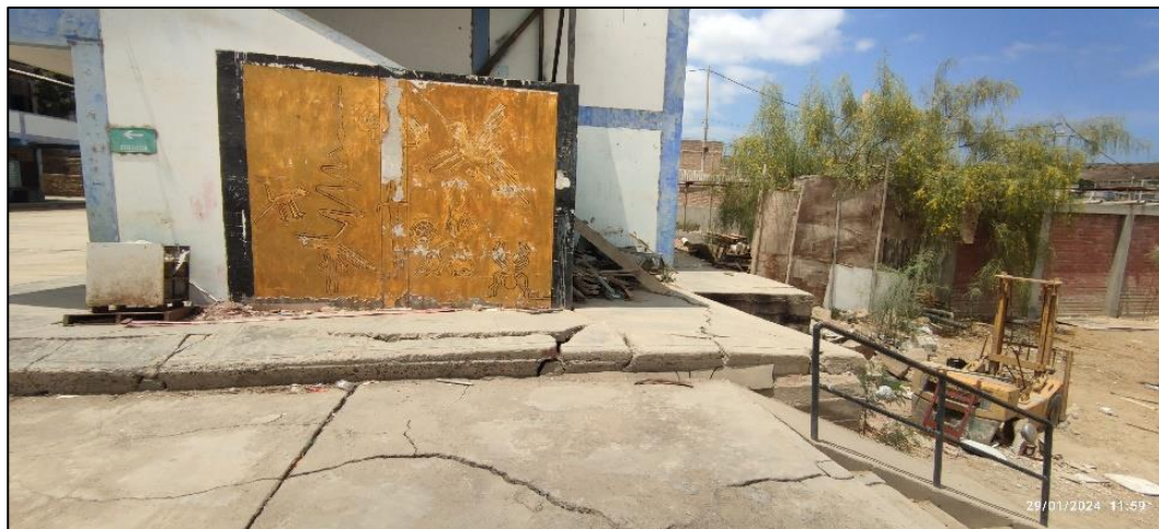
Imagen n.º 65 Estado actual de los pisos
