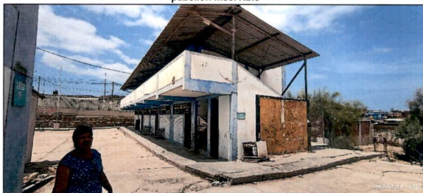
Toma Fotográfica n.º 25 pabellón inservible
