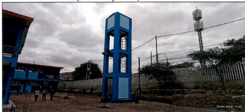
Toma Fotográfica n.º 6 Tanque elevado ejecutado por la contratista
