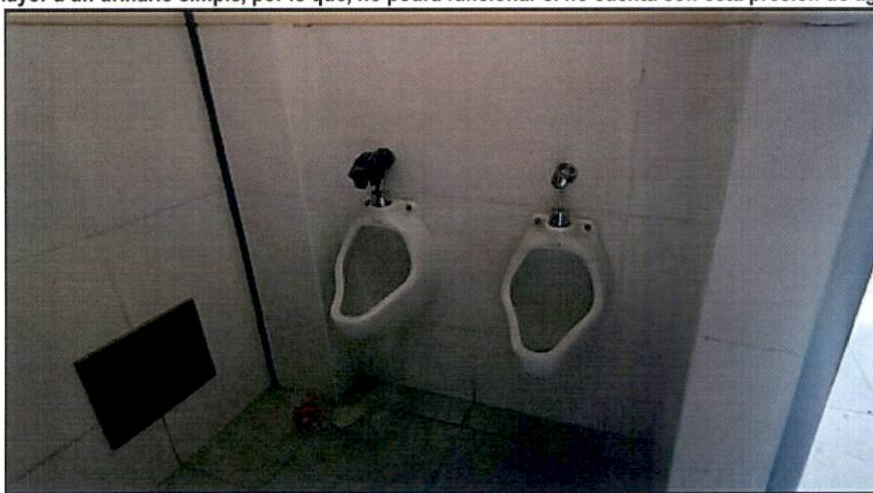
Toma Fotográfica n.º 37 Los urinarios instalados en la ejecución del proyecto son tipo fluxómetros, quiere decir que funcionan con una presión mayor a un urinario simple, por lo que, no podrá funcionar si no cuenta con esta presión de agua
