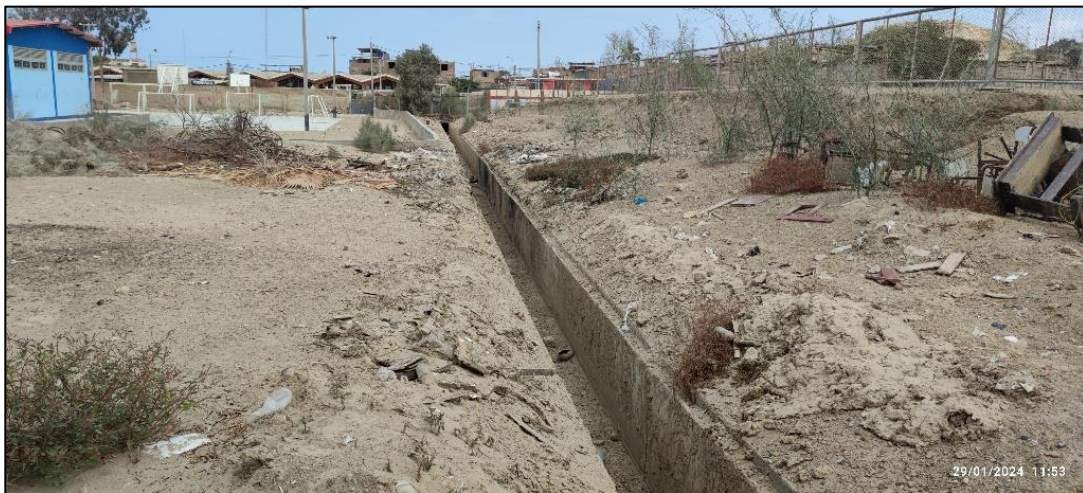
Imagen n.º 39 Canaleta para la evacuación pluvial
