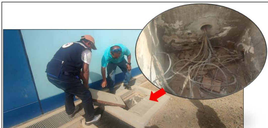
Imagen n.º 9 Tubería de pvc con mayor diámetro instalada por la institución educativa
