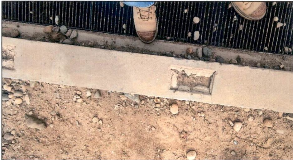
Toma Fotográfica n.º 47 Desprendimiento de barandas de seguridad en ambientes correspondientes al nivel inicial
