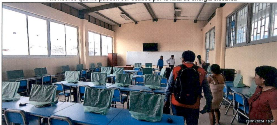
Toma Fotográfica n.º 29 Televisores que no pueden ser usados por la falta de energía eléctrica
