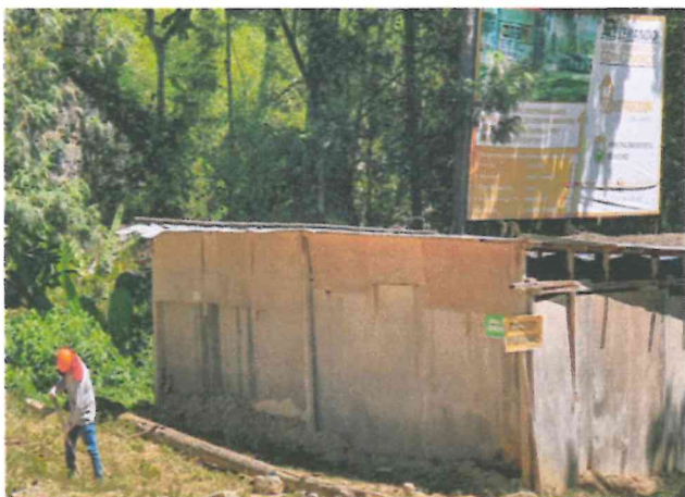
Fotografía 1. Limpieza en exteriores de zona de obra.
