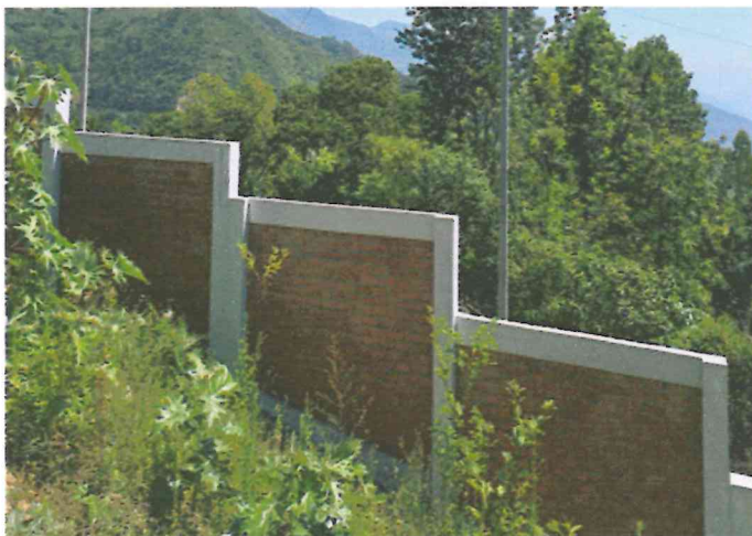
Fotografía 10. Cerco perimétrico de albañilería
