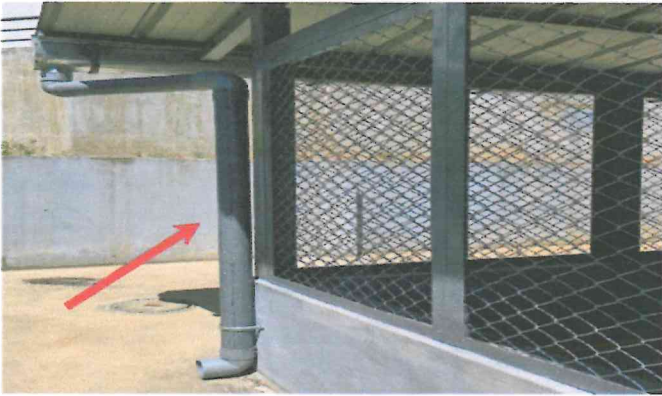
Fotografía 12. Tubería instalada de drenaje pluvial en caseta de tanque de petróleo
