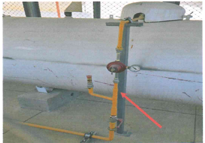
Fotografía 11. Instalación de sistema de petróleo
