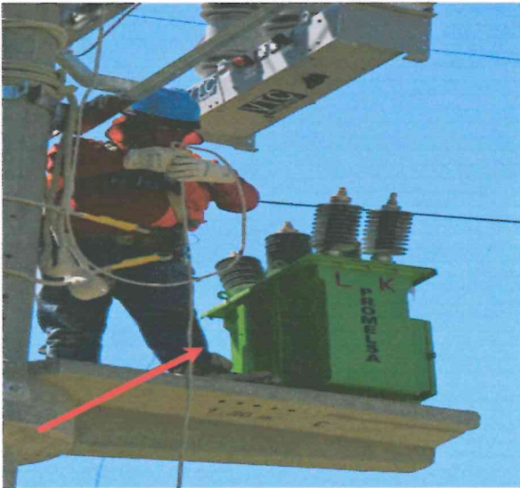
Fotografía 24. Fijación y verificación de montaje de equipos de media tensión
