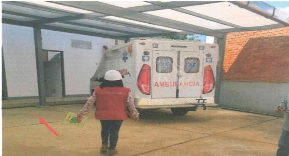
Fotografía 43. En estacionamiento de camioneta y ambulancia se evidencia la ambulancia; sin embargo, no se observó la camioneta.
