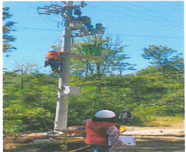
Fotografía 22. Trabajos de aseguramiento de equipo en poste de media tensión.
