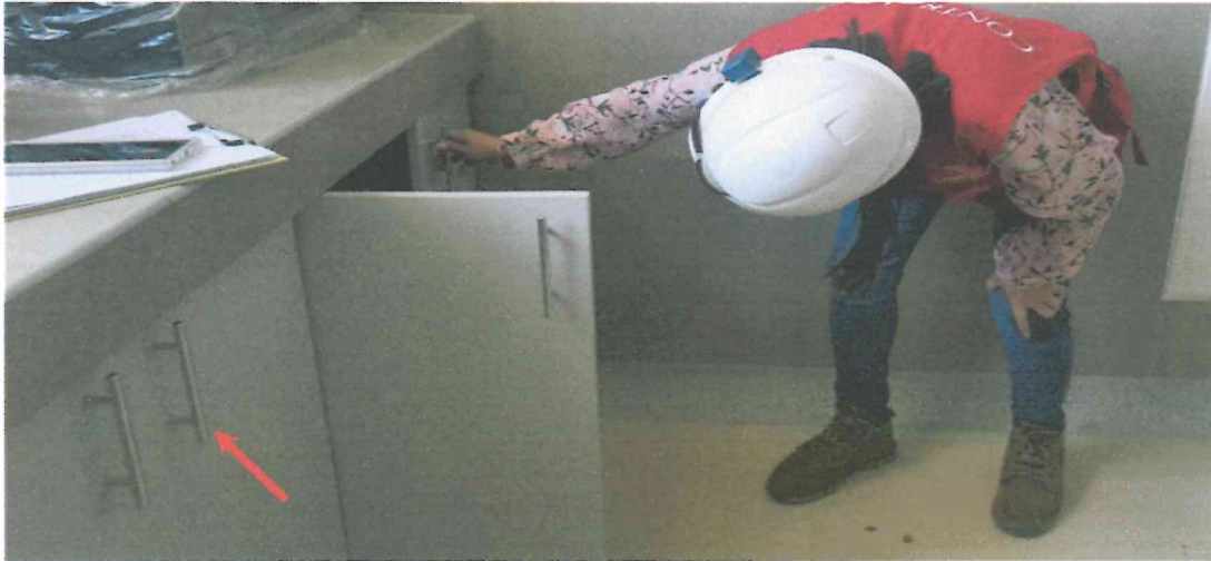
Fotografía 48. En comedor-cocina, se ha instalado mueble de madera bajo; sin embargo no se han colocado cajones (MO-6) y las puertas no abren con facilidad.
