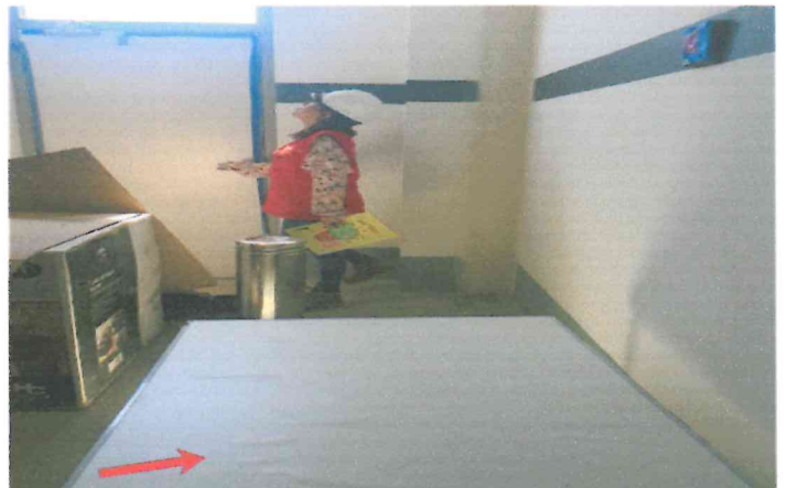
Fotografía 40. Depósito o almacén, se ha instalado mesa de trabajo (M-94) en cuyo tablero se observa ondulaciones. No se ha instalado Teléfono IP (T-20), reloj de pared (T-79), escalera de 3 pasos (M-6), televisor (T-16), reloj de pared (T-79)
