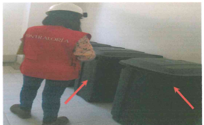
Fotografía 42. En ambiente de acopio y clasific. de residuos sólidos se observa instalación de Contenedores rodable para residuos sólidos (M-164).
