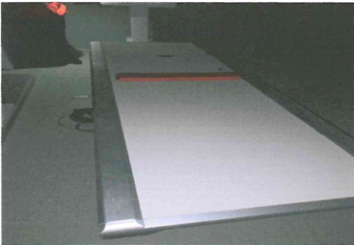
Fotografía 64. En rayos X, se ha instalado de manera parcial equipo estacionario de rayos X (D-20)
