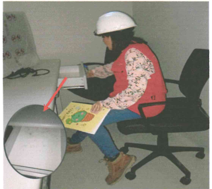
Fotografía 75. En ambiente de entrega de informes se observa instalación de mobiliario, se observa que hay dificultad para abrir y cerrar cajones, así como presencia de humedad en estos
