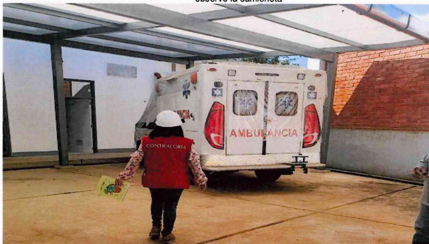
Fuente: Acta de inspección n.º 02-2024-CG/OC0450-RCC/Ley 31358-2426778 de 31 de mayo de 2024
