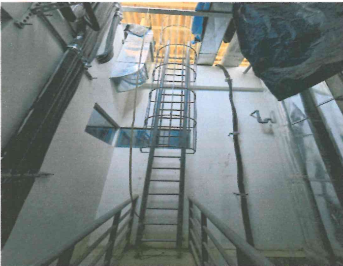
Fotografía 59. Instalaciones de escalera y barandas metálicas en ducto.
