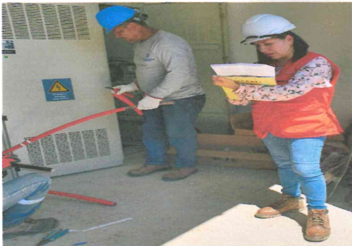
Fotografía 21. Empalme de cable en celdas de llegada y protección a tierra
