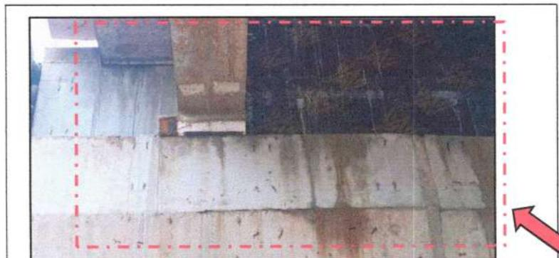
Se evidencia la presencia de paneles de encofrado de la superestructura en la cajuela del puente, asimismo, la presencia de madera y tecnoport en los apoyos.
