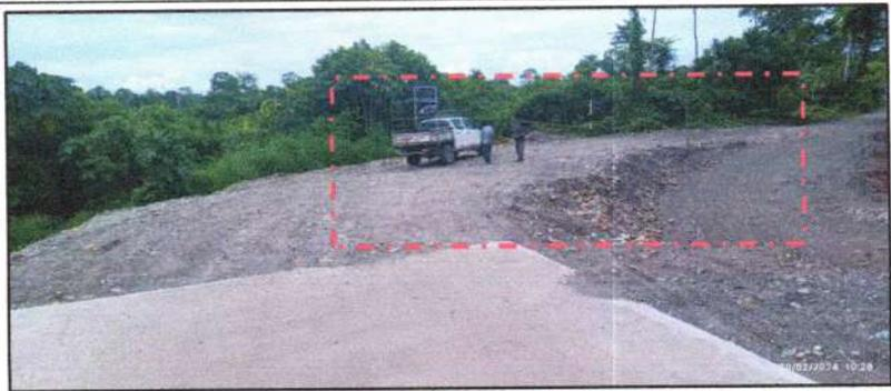
Muestra el acceso del margen derecho, en el cual no se ejecutaron las cunetas en las progresivas 0+000.00 - 0+007.50, 0+092.50 - 0+095.00.
