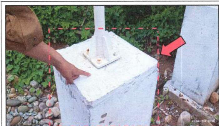
Se evidencia la fisuración en la partida 01.04.04 estructura de soporte de señales tipo e-2 .
