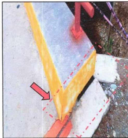
Se evidencia el espesor de 0.20cm de la vereda, asimismo, se puede evidenciar la partida 01.04.05 pintado de parapetos de muros y alcantarillas, el cual se encuentra desprendido y desgastado.
