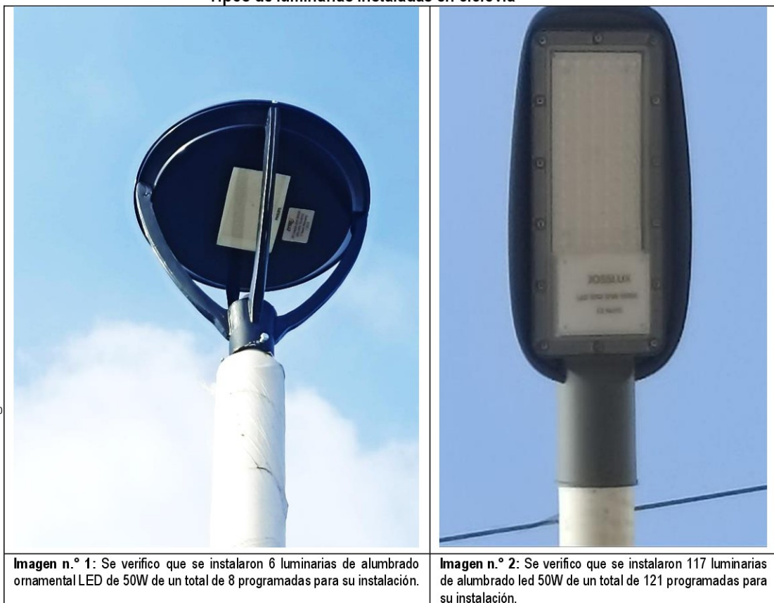
Imágenes n.ºs 7 y 8 Tipos de luminarias instaladas en ciclovía
