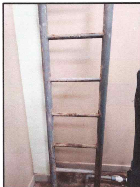
FOTO N° 06.- VOLVER A PINTAR LA ESCALERA DE GATO DEL TANQUE ELEVADO.
