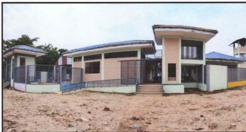
FOTO N° 01.- COLOCAR Y PINTAR EL NOMBRE DE LA I.E.
