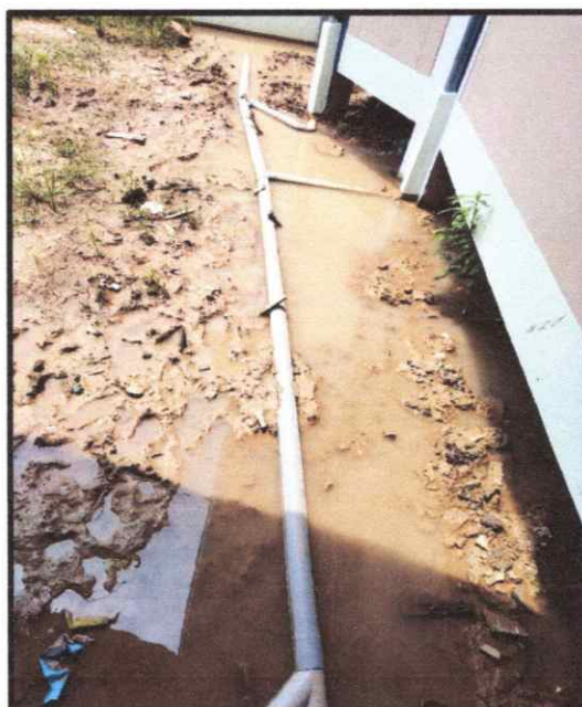
FOTO N° 08.- TAPAR LA TUBERÍA DE PVC DE DRENAJE PLUVIAL.
