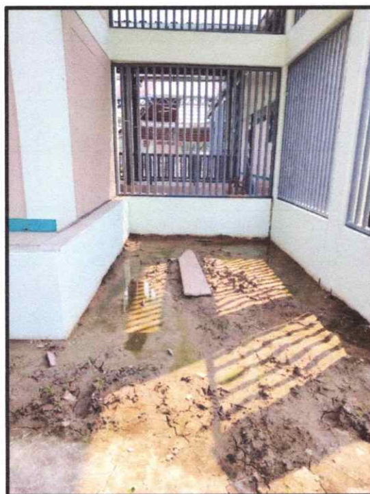
FOTO N° 02.- REALIZAR EL MEJORAMIENTO DE LA FACHADA, COLOCAR MATERIAL MEJORADO
