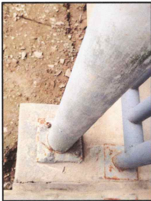
FOTO N° 03.- VOLVER A PINTAR LA BASE DE LAS BARANDAS DEJANDO LIBRE DE OXIDOS.
