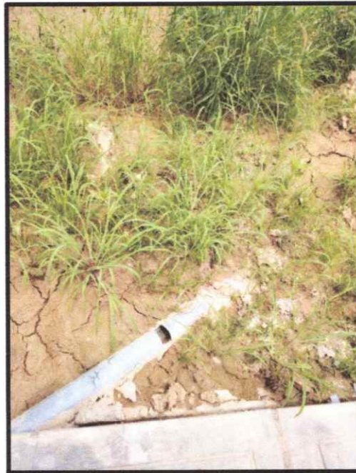
FOTO N° 12.- COLOCAR UNA CAJA DE CONCRETO DE PASE PARA EVACUAR LAS AGUAS PLUVIALES
