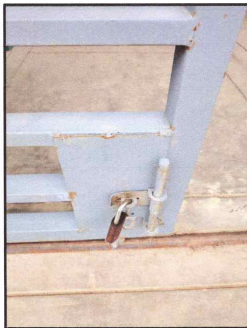
FOTO N° 04. VOLVER A PINTAR LA PUERTA DE INGRESO DEJÁNDOLO LIBRE DE ÓXIDO.
