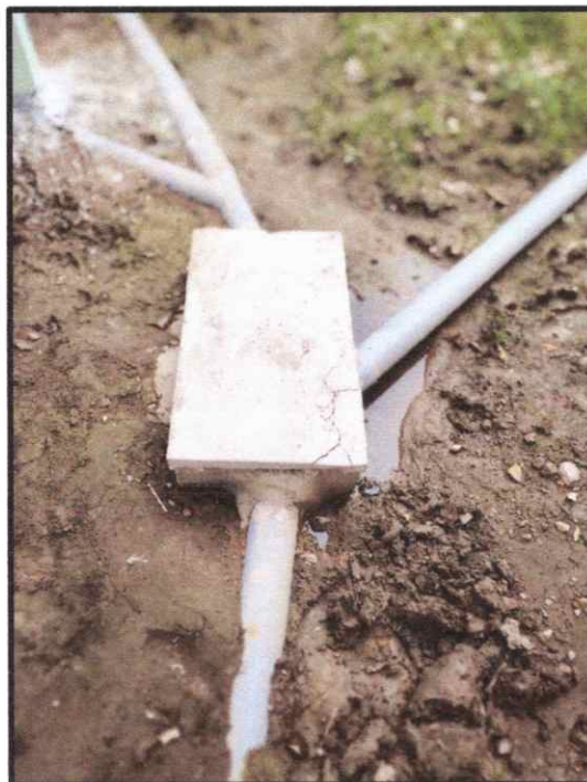
FOTO N° 07.- PROTEGER LOS TUBOS DE PVC Y CONFECCIONAR OTRA CAJA.
