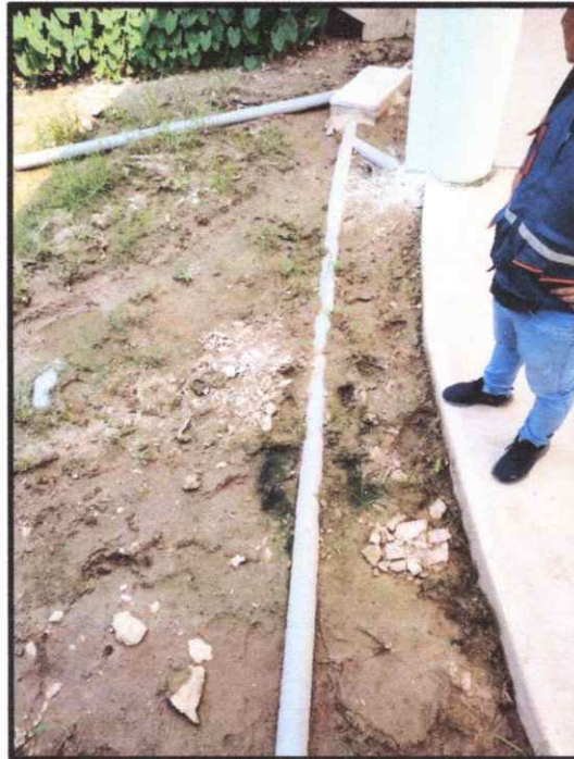
FOTO N° 09.- TAPAR Y PROTEGER LAS TUBERÍAS DE DRENAJE PLUVIAL.
