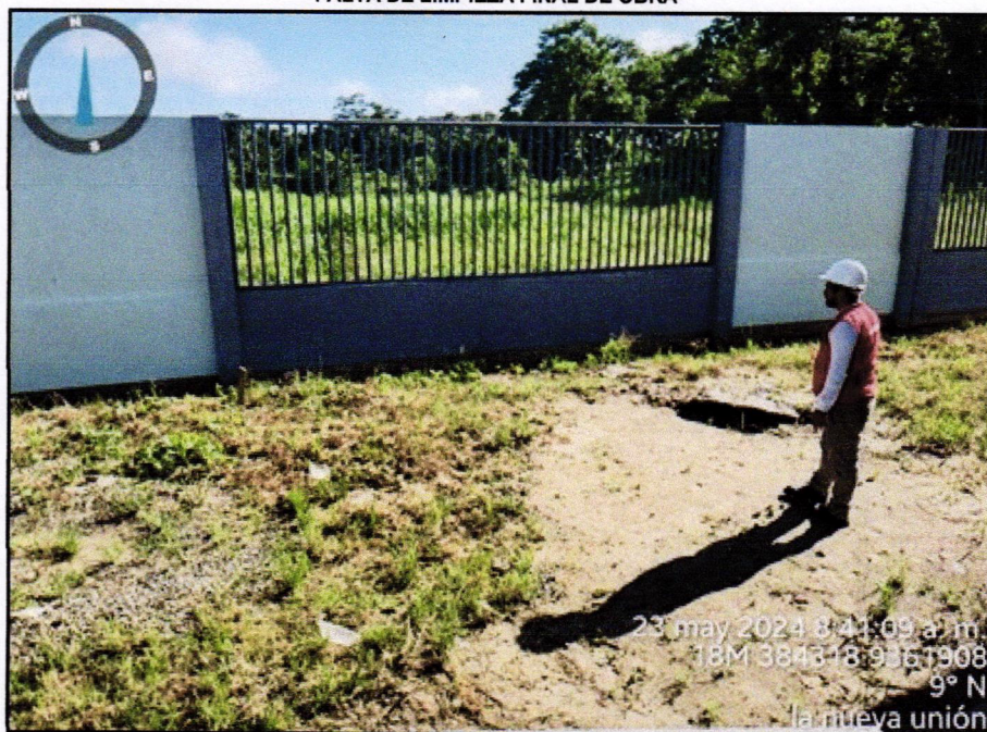
IMAGEN N° 5 FALTA DE LIMPIEZA FINAL DE OBRA
