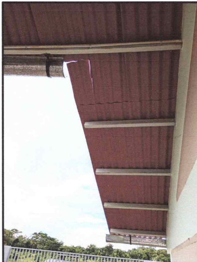
FOTO N° 14.- PLANCHAS DE CALAMINA ROTAS, EN CASETA GRUPO ELECTRÓGENO
