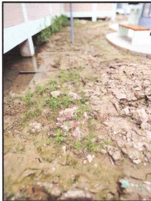
FOTO N° 10.- NIVELAR EL TERRENO DE INGRESO A LOS ACCESOS.
