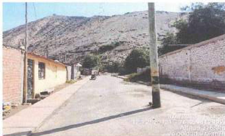
Foto 28. Peste de MT en la cancha, Caylla, provincia de Canete, coordenada: -12.72628131; -76.45941289.
