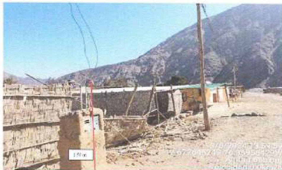
Foto 85. Conductor de acometida a 1.50 m del suelo, anexo Santiago La Yesera, provincia de Cuzco, coordenadas: 12.67261824; 76.16955429.
