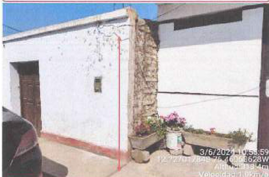
Foto 44. Conductor de antena a 1,90 de distancia vertical de la cumbre, Coaylla, provincia de Canete, coordenada: -11.72701784S; -76.46063628W.
