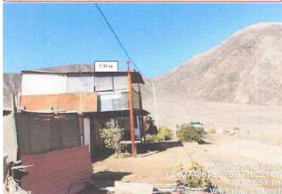
Foto 80. Conductor autoportante sobre plano a 5,20 m de distancia vertical, anexa Santiago La Yezera, provincia de Cañete, coordenada: -12.67743618; -76.37182214.
