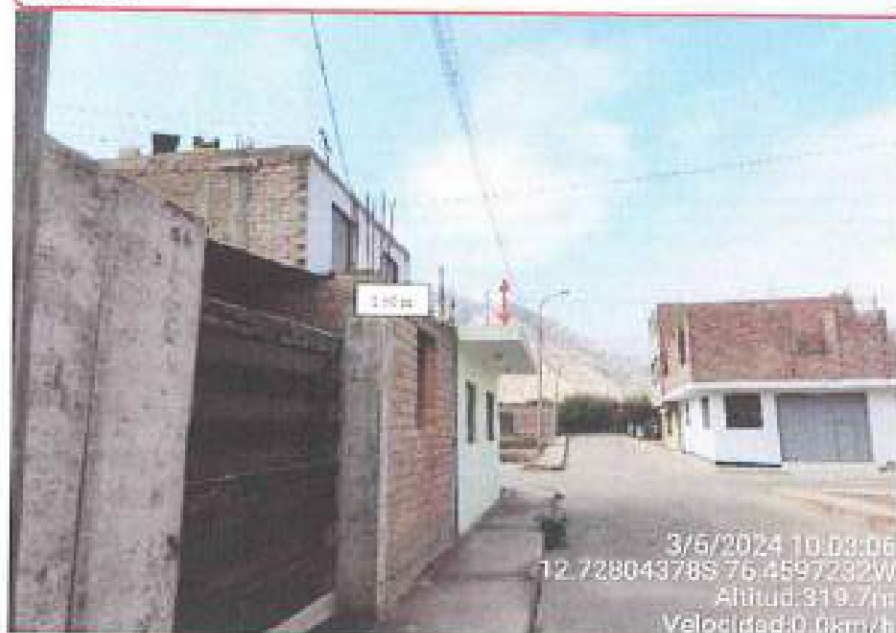
Foto 14. Conductor de HT tipo CPI sobre cable a 55m de distancia vertical, Coaylla, provincia de Cañete, coordenadas: 12.72804378S - 76.4597232W.
