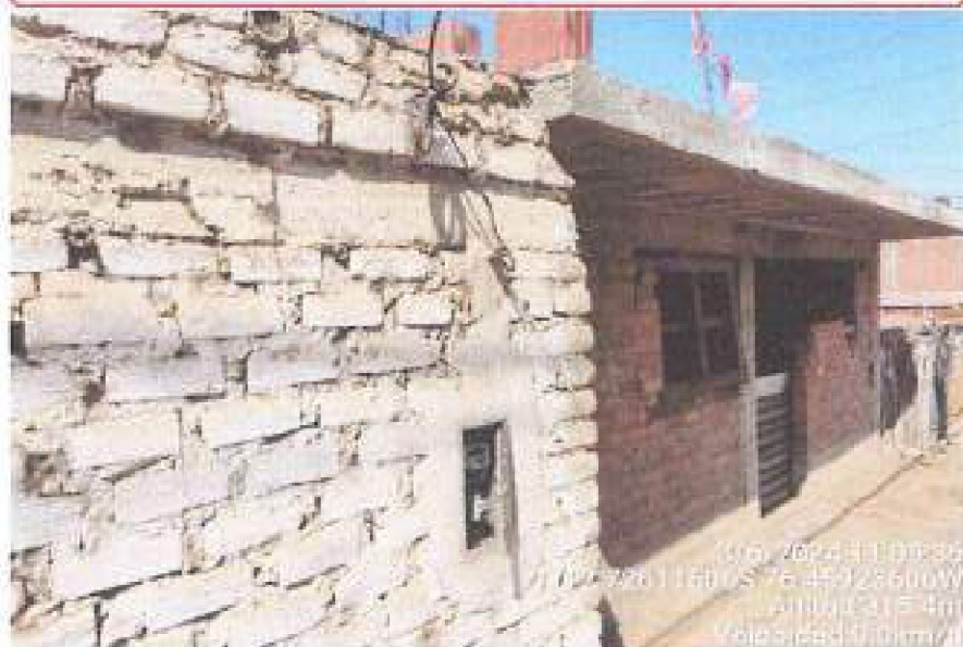
Foto 29. Caja portamuebles con tapa abierta, Caylla, provincia de Canete, coordenada: -12.72611696; -76.45923686.
