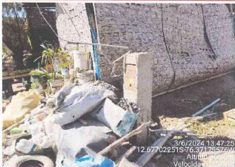
Foto 82. Conductor de acometida a 1.90 m del surfo, anexo Santiago La Yevera, provincia de Canete, coordenada: 12.6770225; 76.3717557.
