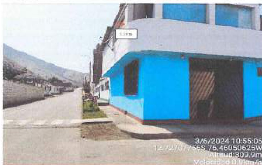
Foto 43. Conductor RT autoportante a 6,80 m de distancia horizontal de edificación, Coaylla, provincia de Canete, coordenada: -11.72701756S; -76.46050625W.
