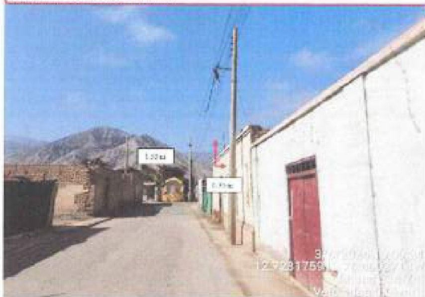
Foto 15. Conductor de BT autoportante a 0,40 m de pared de edificación, Coaylla, provincia de Cañete, coordenadas: 12.3781389; -76.4601995.
