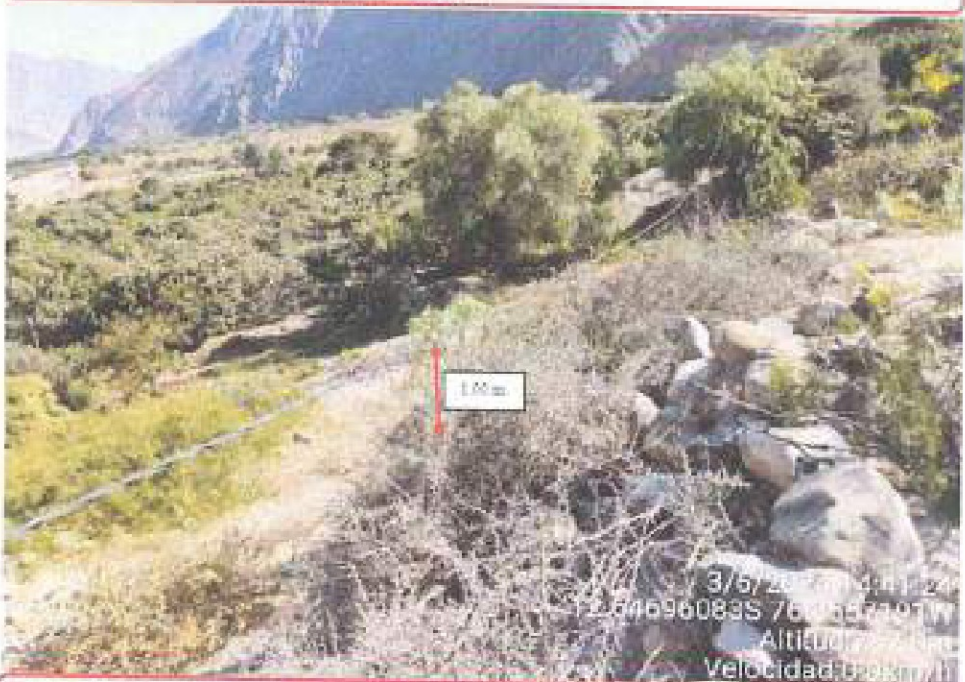
Foto 96. Conductor de BT anteparamento a 100 m. de distancia vertical del suelo, anexo Huamantla, provincia de Cusco, coordenada: -12.64696083; -76.3557191.
