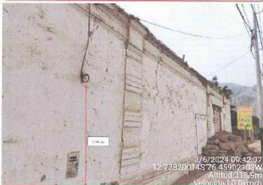
Foto 06. Conductor de acometida a 1.50 m de distancia vertical de la vereda, Coaylla, provincia de Cañete, coordenada: 12.72820014; -76.45902103/página 23 de 78
