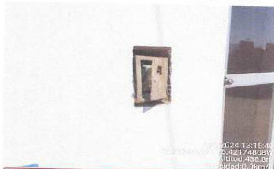
Foto n.º 3. Caja portamedidor con tapa abierta, anexo Uquira, provincia de Canete, coordenadas: -12.71244022; -76.42174808.
