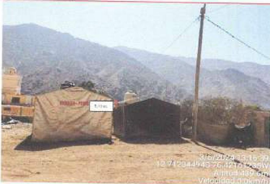
Foto n.º 1. Conductor de BT sobre edificación, anexo Uquira, provincia de Canete, coordenadas: -12.71234494; -76.42174235.
