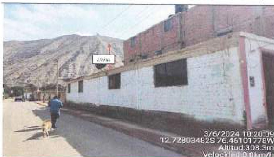
Foto 20. Conductor de BT tipo CPI sobre edificación a 200 m de distancia vertical, Coaylla, provincia de Cañete, coordenada: 12.72803482; -76.46101778
