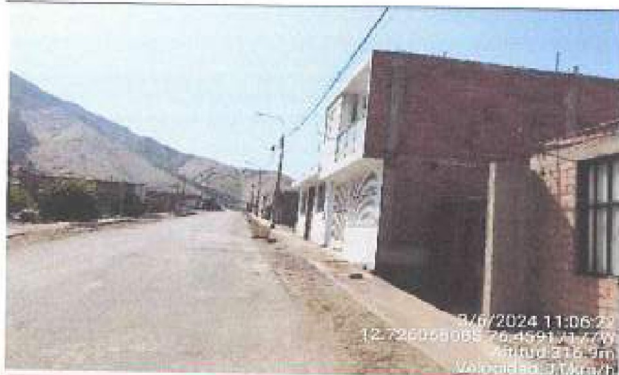
Foto 51. Conductor de BT autoportante a 0.80 m de distancia horizontal de ventana de edificación, Coaylla, provincia de Canete, coordenadas: 12.726048085 - 76.45917177.
