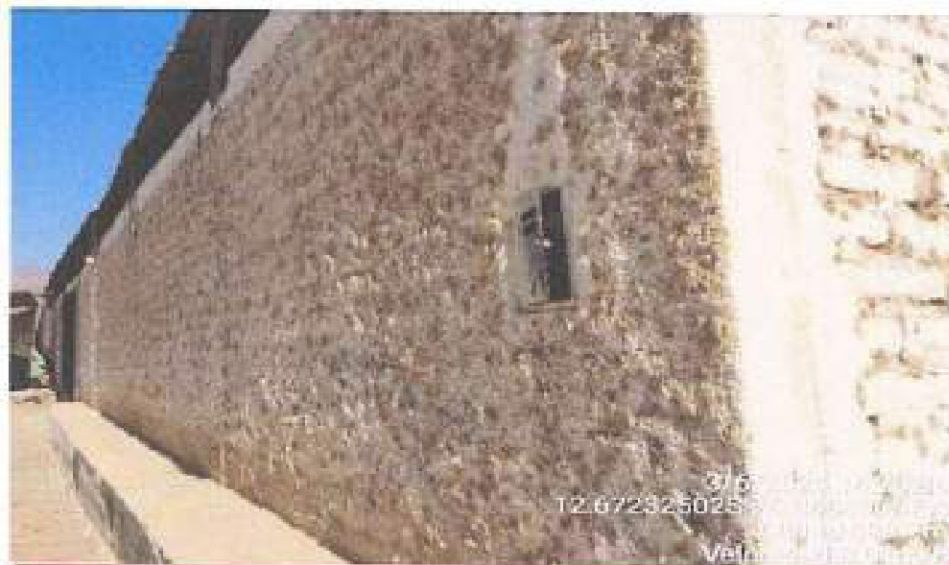
Foto 90. Caja portamedidor con tapa abierta, anexo Santiago La Yevera, provincia de Cañar, coordenada: -12.67282402; -76.36889057.
