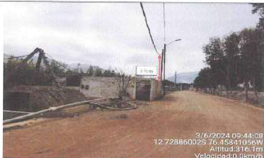
Foto 06. Conductor autoportante sobre edificación a 3,50 m de distancia vertical. Coaylla, provincia de Cañete, coordenada: -12.72886002; -76.45841056.
