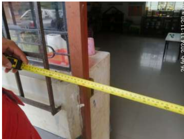
Imagen n.º 6 Medida del Ancho de Puerta en las aulas de la IE
