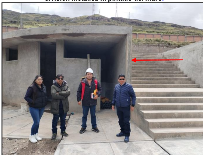
Fotografía n.º 2 Servicios Higiénicos sin ventanas metálicas, división metálica ni pintado del muro.
