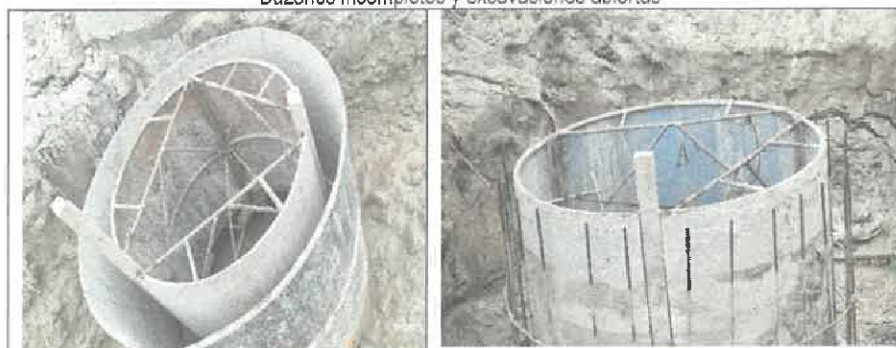
Imagen n.º 12 Buzones incompletos y excavaciones abiertas
