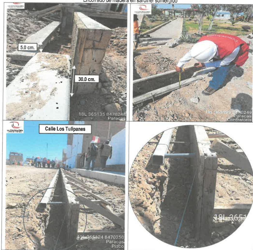
Imagen n.º 3 Encofrado de madera en sardinel sumergido
