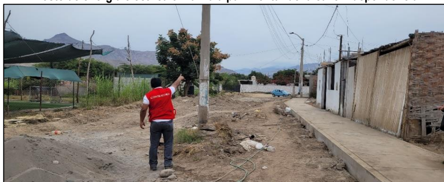
Imagen n.° 12 Poste de energía eléctrica en la vía a pavimentar de la calle Independencia
