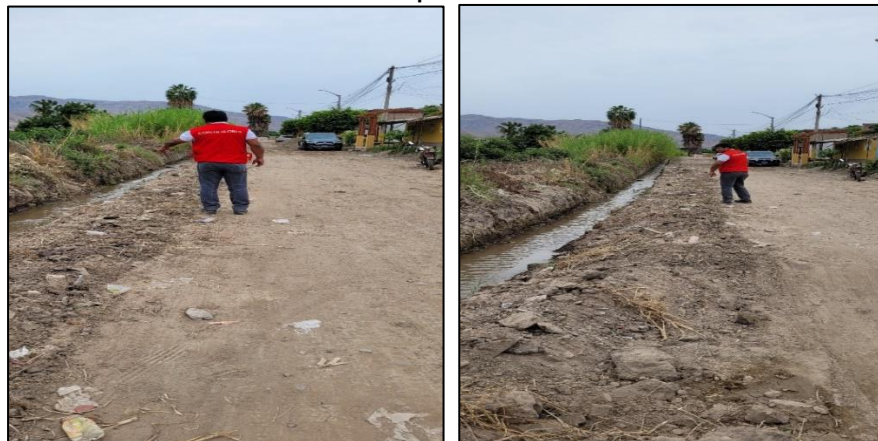
Imagen n.° 11 Canal de riego natural sin revestimiento, adyacente a la vía a pavimentar en la calle Independencia
