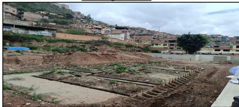
Fuente: Vista de inspección física de 19 de enero de 2024.
