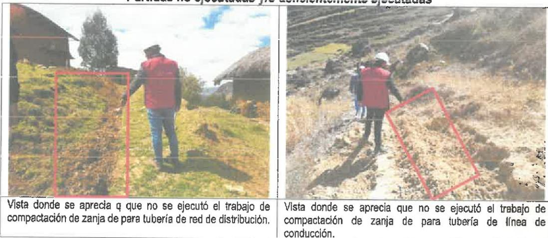
Vista donde se aprecia q que no se ejecutó el trabajo de compactación de zanja de para tubería de red de distribución.
