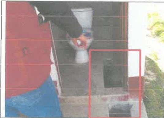
Vista donde se aprecia que las partidas PISO DE CONCRETO FC=175kg/cm<sup>2</sup> y VEREDA DE CONCRETO f°c=175kg/cm<sup>2</sup> no fueron ejecutadas al 100%.
