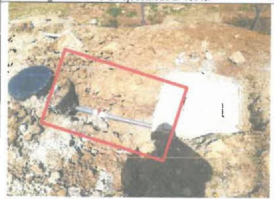
Vista donde se aprecia que la partida SEGUNDO RELLENO COMPACTADO DE ZANJA PARA TUBERIA CON MATERIAL PROPIO e=50cm no fue ejecutada al 100%.
