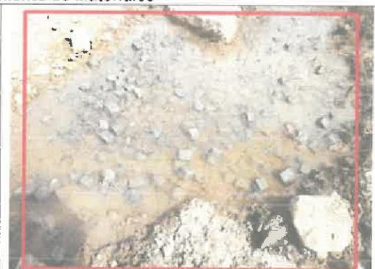
Vista donde se aprecia el inadecuado almacenamiento de los dados de concreto, sumergidos en el agua y expuestos a la intemperie, ocasionando el deterioro de estos.
