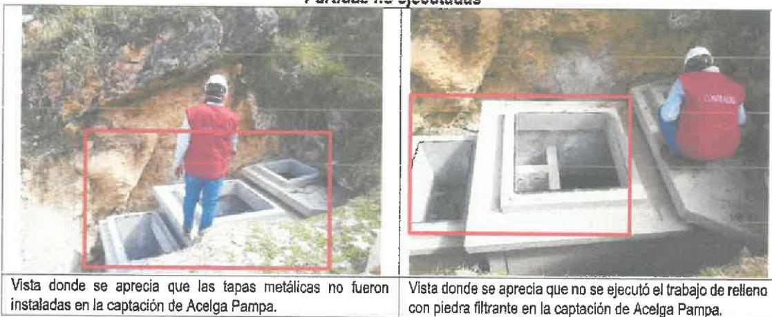
Vista donde se aprecia que las tapas metálicas no fueron instaladas en la captación de Acelga Pampa.
