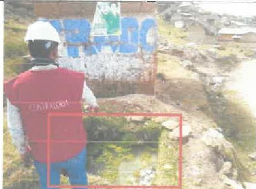
Vista donde se aprecia el inadecuado almacenamiento de los dados de concreto, sumergidos en el agua y expuestos a la intemperie, ocasionando el deterioro de estos.
