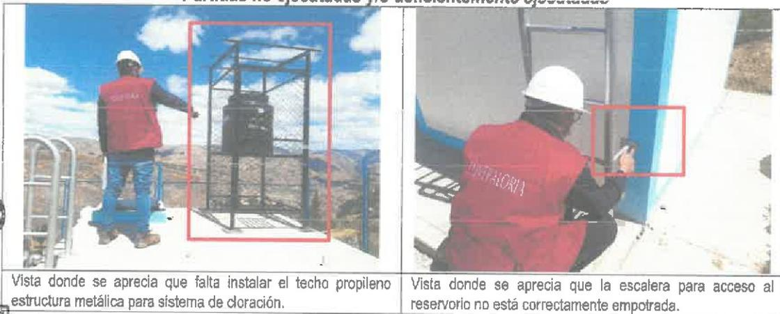
Vista donde se aprecia que falta instalar el techo propileno estructura metálica para sistema de cloración.
