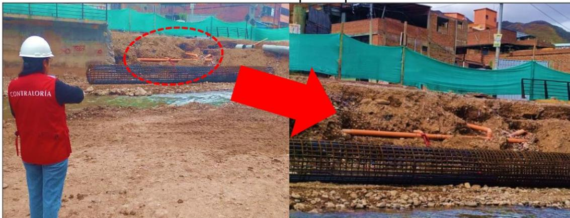
**Imágenes n.ºs 1 y 2:** Tubería de la red de desagüe se encuentra expuesta a la intemperie, producto de las excavaciones realizadas para el estribo izquierdo.
