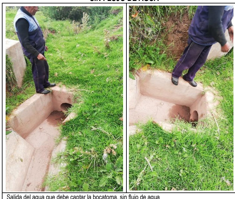
Salida del agua que debe captar la bocatoma, sin flujo de agua
