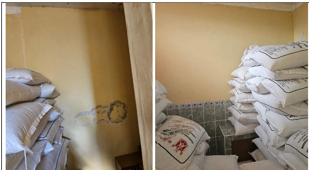
Fuente: Registro fotográfico de la Visita de Control efectuada el 13 de febrero de 2023.
