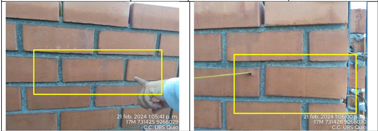
Deficiencia en el asentado de muro - Presencia de ladrillos desalineados en muro de acabado cara vista.
