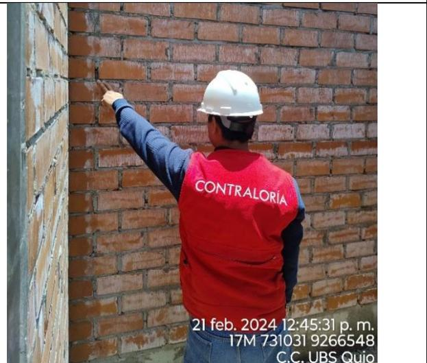
Paredes de las casetas de las UBS muestran presencia de una sustancia salina en las caras del ladrillo.
