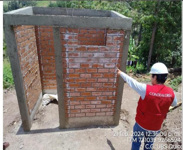
Paredes de las casetas de las UBS muestran presencia de una sustancia salina en las caras del ladrillo.
