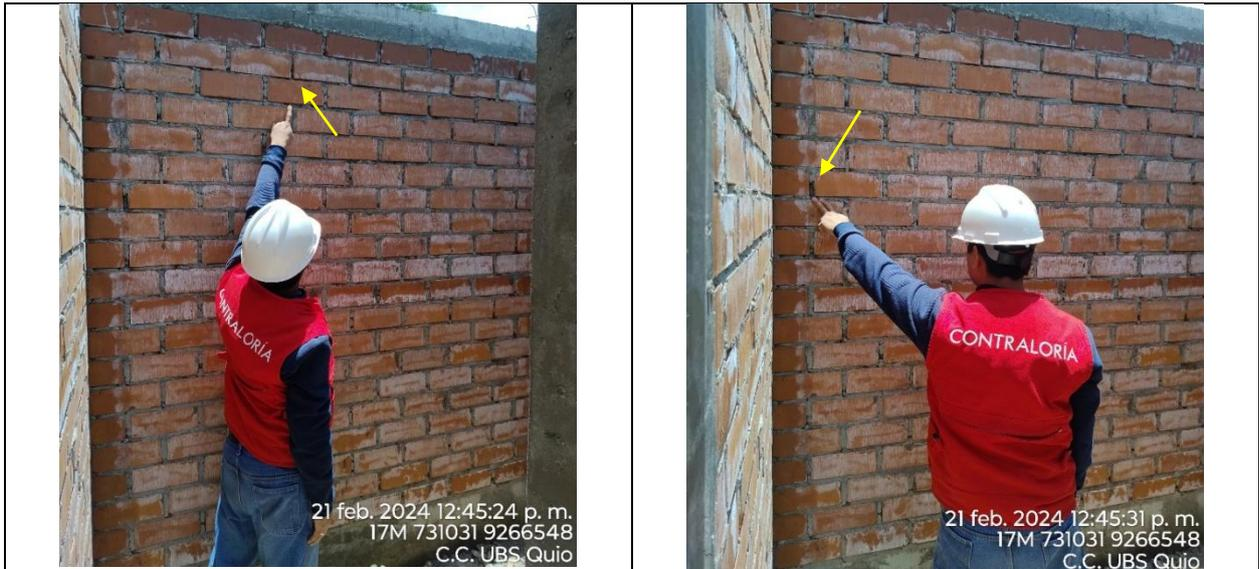
Asentado de muro kk 18 huecos - Las juntas horizontales y verticales no están llenadas completamente con el mortero.
