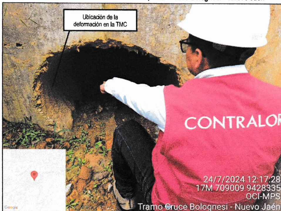
Imagen n.º 2 Alcantarilla TMC \varnothing 36" de km 4+145, tramo cruce Bolognesi – Nuevo Jaén
