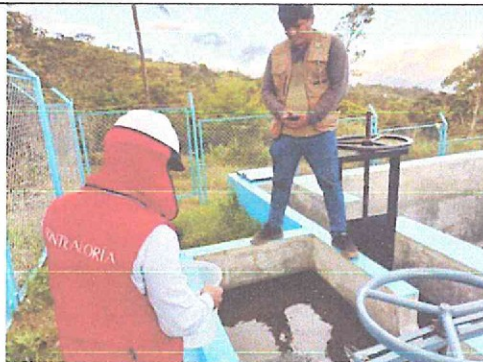
Imagen n.º 17: Procedimiento de medición del caudal en el punto de llegada de la línea de conducción al filtro lento.
