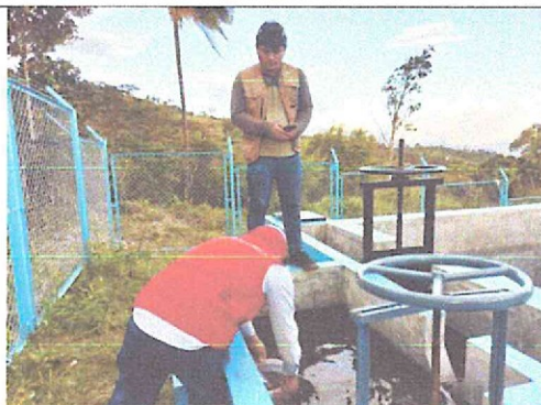
Imagen n.º 19: Aforo del caudal en la PTAP
