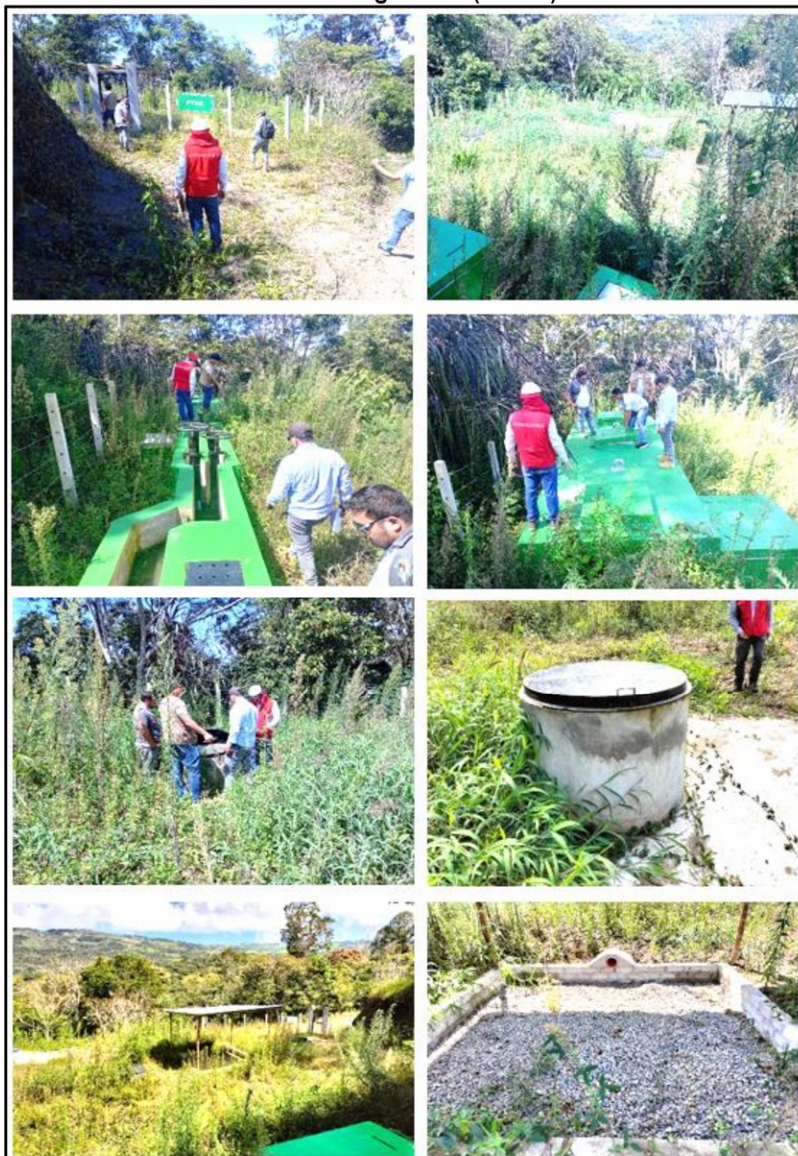
Imagen n.º 13 Presencia de vegetación (maleza) en la PTAR
