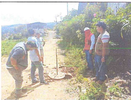
Imagen n.º 58: Inspección de buzón camino al caserío El Tingo
