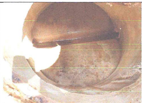
Imagen n.º 59: Inspección del interior del buzón camino al caserío El Tingo
