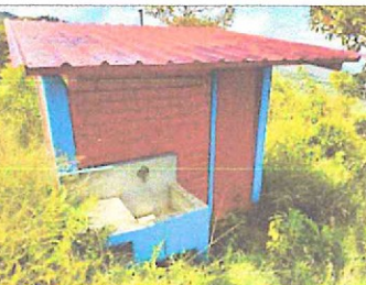
Imagen n.º 47: Conexión C-107
