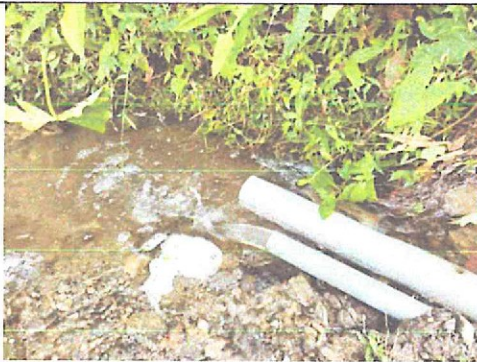
Imagen n.º 11: Salida de agua en la tubería de rebose de la captación.
