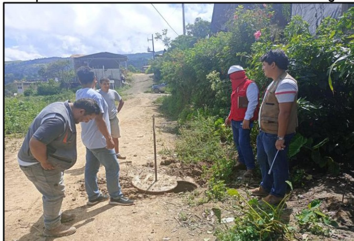
Imagen n.º 10 Inspección de buzón ubicado en la salida al caserío El Tingo
