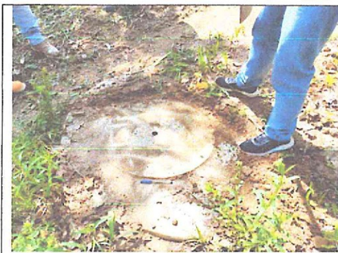
Imagen n.º 56: Verificación de tapas de inspección de buzones camino a la PTAR
