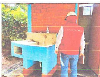
Imagen n.º 38: Conexión C-17
