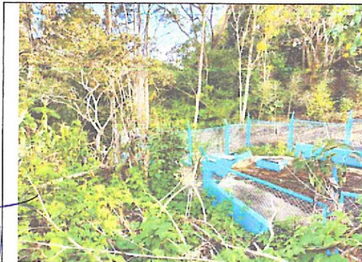
Imagen n.º 3: Presencia de maleza en el exterior e interior al cerco perimétrico de la captación.
