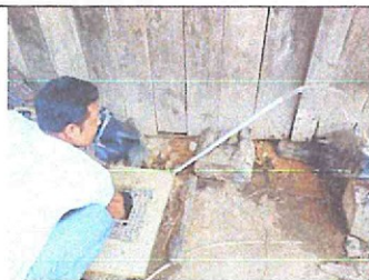
Imagen n.º 41: Conexión C-42
