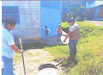
Imagen n.º 60: Inspección de buzón frente al beneficiario de la vivienda codificada con "C-58".
