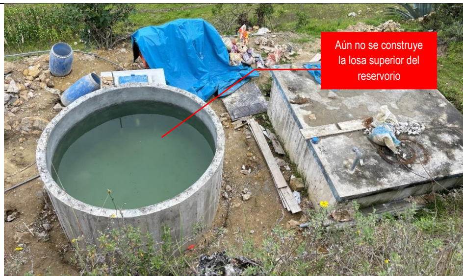
Imagen n.º 3: Se observa que aún no se ha construido la losa superior del reservorio.
