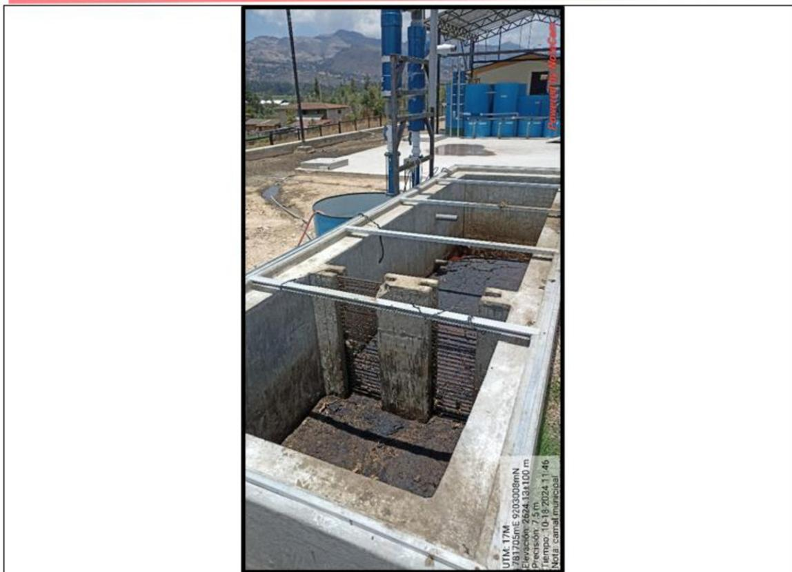
**Fotografía n.º 18:** Se observa la cámara de rejas con sólidos en su interior producto del traslado de pelaje, grasas, y restos de los animales sacrificados que no son retenidos en las rejillas de las áreas de beneficio.
