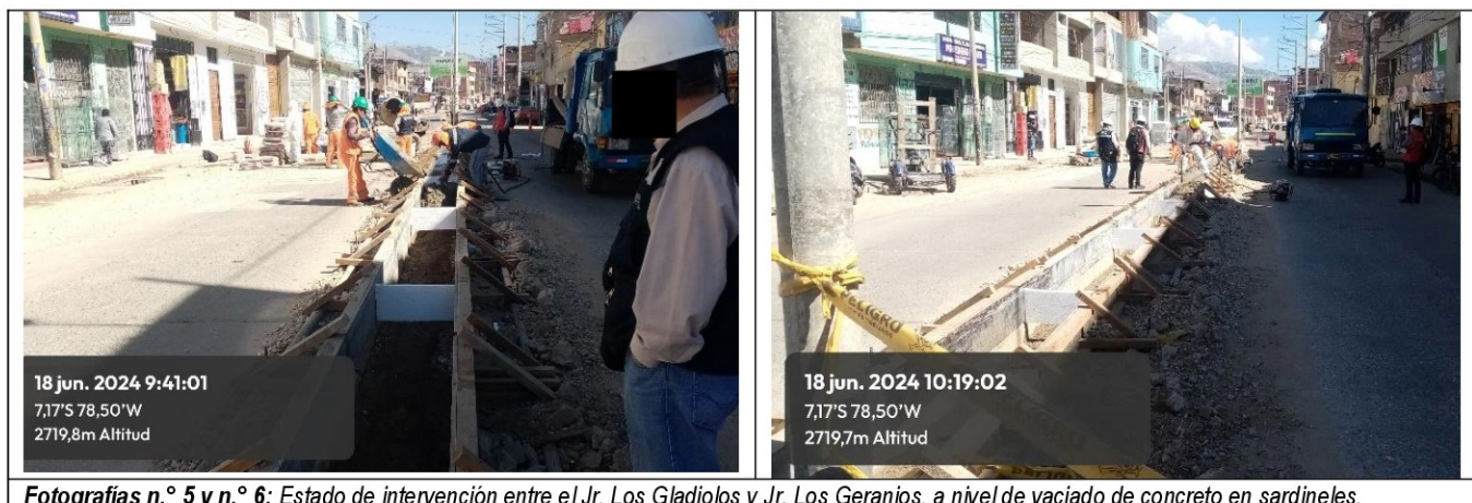
Fotografías n.º 5 y n.º 6: Estado de intervención entre el Jr. Los Gladiolos y Jr. Los Geranios, a nivel de vaciado de concreto en sardineles.
