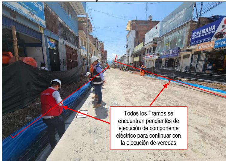
**Fotografía n.º 1:** inspección de Obra del componente eléctrico y telecomunicación
