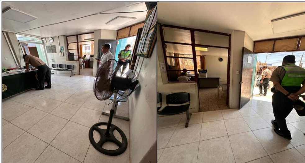
Imágenes n.º 8 y 9 Zona de servicios higiénicos sin señalética.
