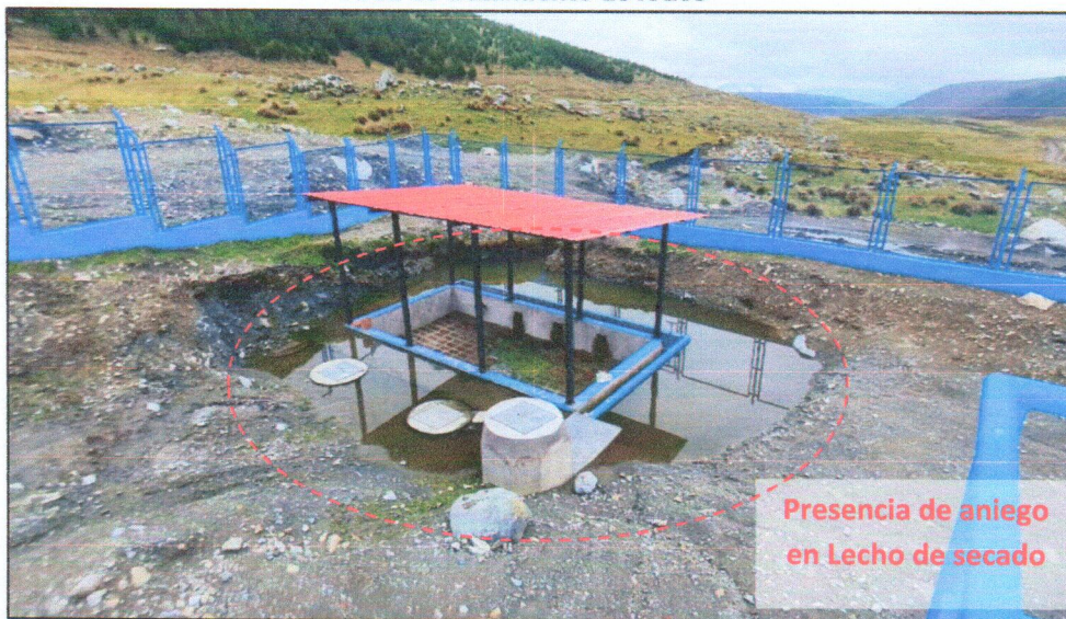
Imagen n.º09 Área de tratamiento de lodos
