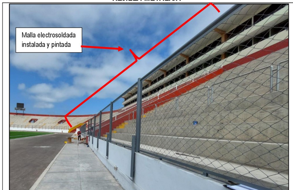
Malla electrosoldada instalada
