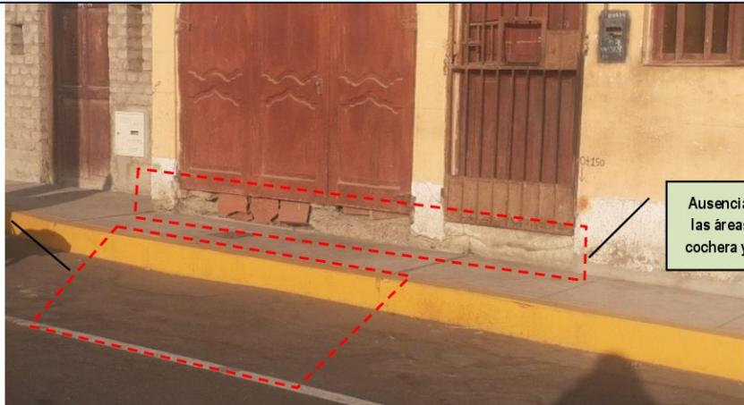
Ubicación de la Rampa Vehicular de concreto (3.00 x 1.50 m²) no ejecutada
