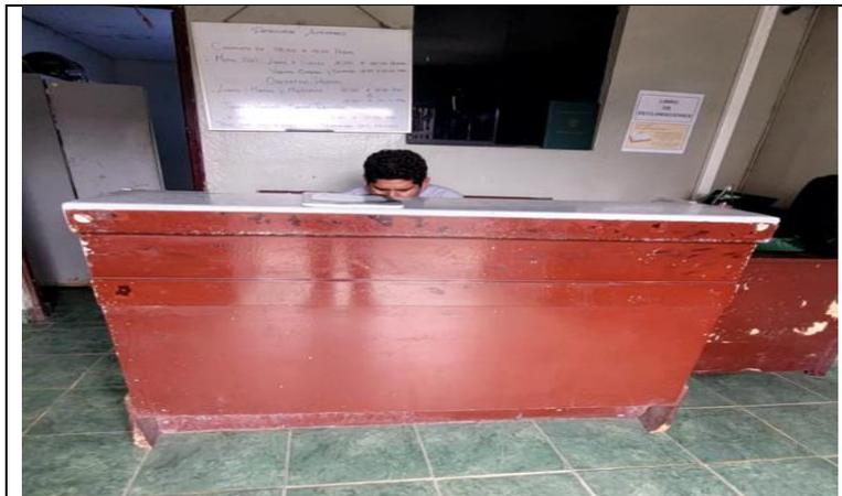
Como se evidencia en la fotografía el mobiliario de atención al público, tiene un ancho y alto mayor al 0.80m, pues posee un ancho de 1.10m y alto de 95cm
