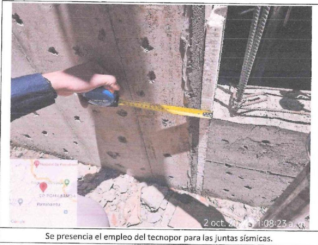
Se presencia el empleo del tecnopor para las juntas sísmicas.
