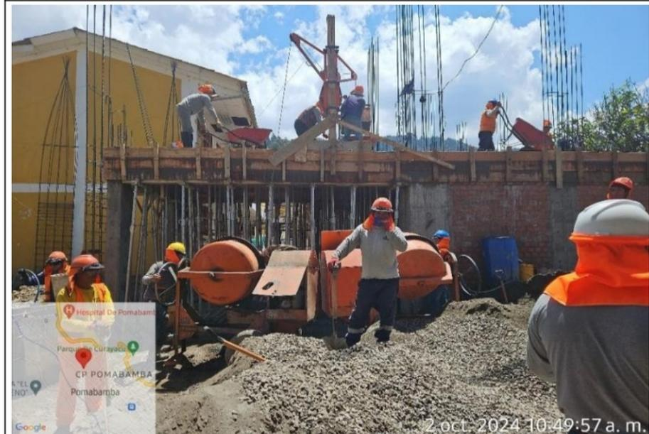
En la parte superior se evidencia la falta de barandas de seguridad así como la no implementación del arnés de seguridad.
