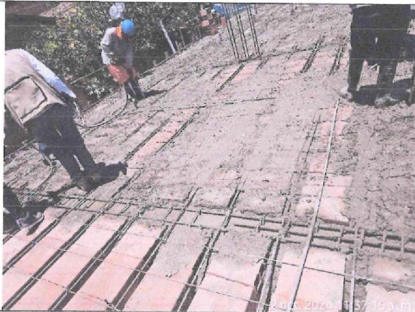
Se evidencia el proceso de vibrado del concreto de la losa aligerada.
