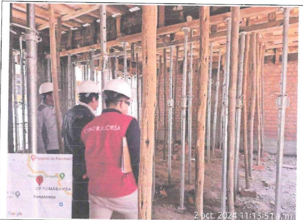
Se evidencia el uso de pies derechos y tablas nuevas para el encofrado de la losa y vigas peraltadas.
