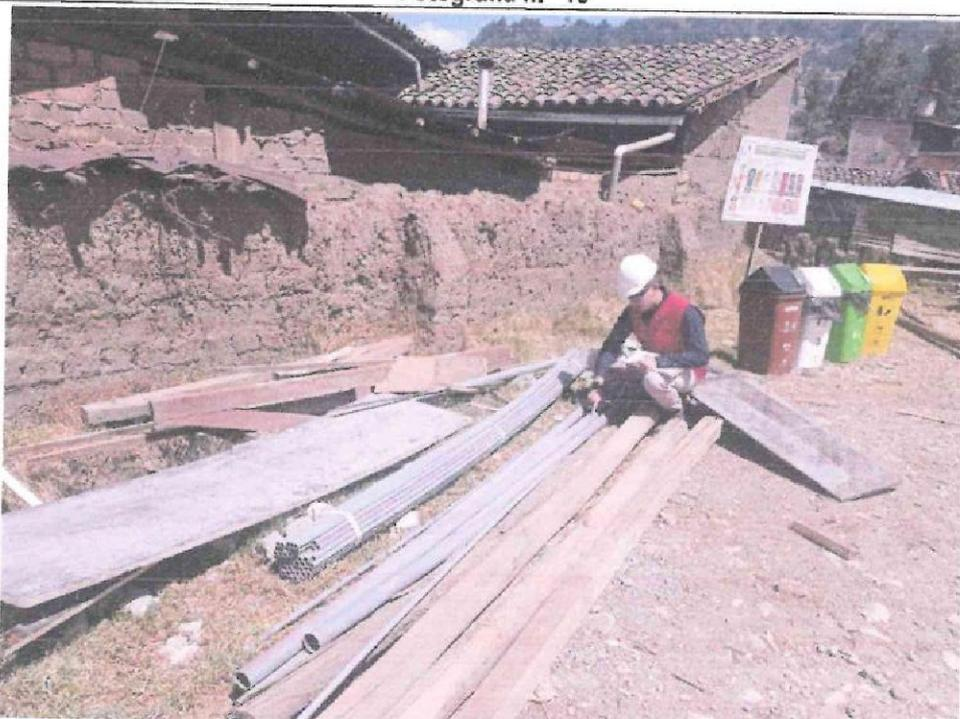
Se evidencia el acopio y protección deficiente de las tuberías de PVC dentro del área de almacén de materiales de construcción.
