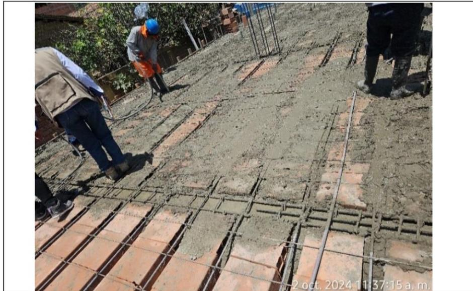
Se evidencia el vaciado del concreto de losa aligerada del módulo de aulas.
