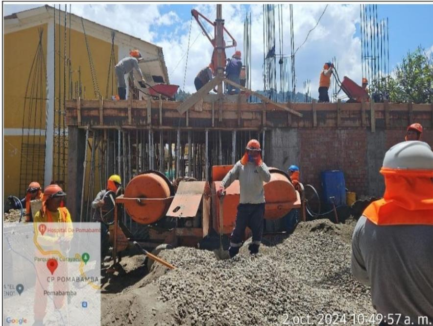
El personal obrero encargado del vaciado no cuenta con Traje Tyvek ni mascarillas, lo que los dejaría expuesto a la irritación de vista y piel por estar en contacto directo con el cemento y concreto.
