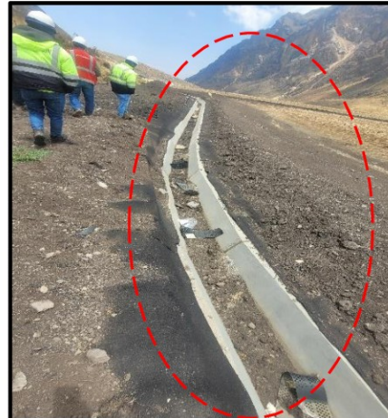
FOTOGRAFÍA N° 6 NO EXISTE ORDEN Y LIMPIEZA EN EL ÁREA DE TRABAJO ID 5038, DONDE SE ENCONTRÓ SOBRAS DE GEOSINTÉTICOS EN EL INTERIOR DE LAS CUNETAS
