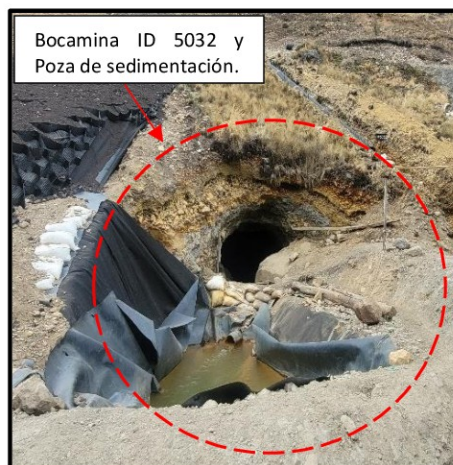
FOTOGRAFÍA N° 8 CAPTACIÓN DEL DRENAJE ÁCIDO DE LA BOCAMINA ID 5032
