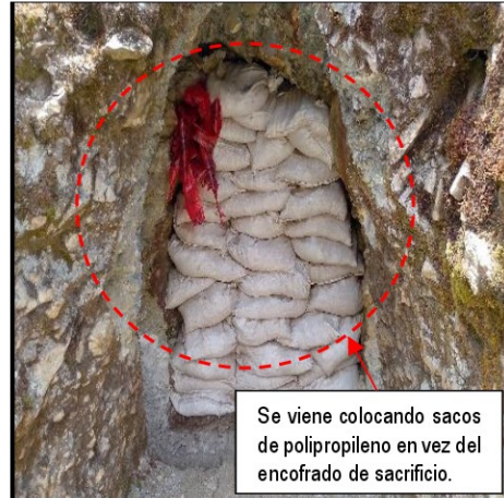
FOTOGRAFÍA N° 18 INTERIOR DE LA BOCAMINA ID 14686, DONDE SE PROYECTÓ ENCOFRADO DE SACRIFICIO
