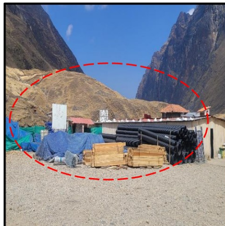
FOTOGRAFÍA N° 3 NO EXISTE ORDEN Y LIMPIEZA EN EL ALMACÉN DONDE SE GUARDAN LAS MADERAS, TUBOS, ALAMBRES Y TAMPOCO ESTÁ SEÑALIZADO
