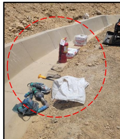
FOTOGRAFÍA N° 4 NO EXISTE ORDEN Y LIMPIEZA EN EL ÁREA DE TRABAJO ID 5038, DONDE SE ENCONTRÓ UN EXTINTOR AL DORDE DE LA CUNETA, ASI COMO HERRAMIENTAS MANUALES
