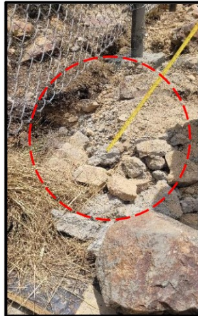
FOTOGRAFÍA N° 5 NO EXISTE ORDEN Y LIMPIEZA EN EL ÁREA DE TRABAJO ID 5038, DONDE SE ENCONTRÓ SOBRAS DE CONCRETO EN LOS CERCOS PERIMÉTRICOS
