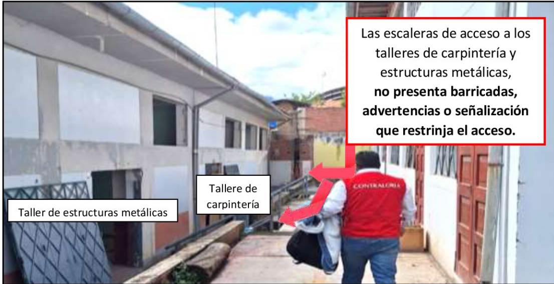
Fuente: Acta de inspección física N° 001-2024-OCI/MPHi/ARCM/2473481, de 26 de noviembre de 2024.
