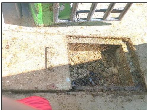
**TANQUE SÉPTICO LLENO, CON PRESENCIA DE MATERIAL ORGÁNICO SÓLIDO**
