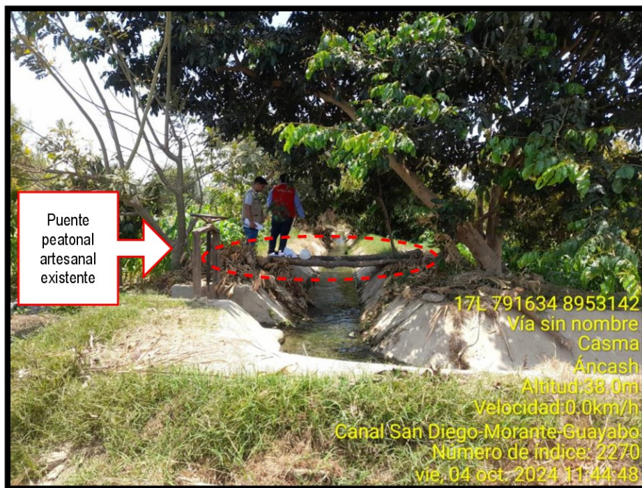
FOTOGRAFÍA N° 4 CANAL DE SECCIÓN TRAPEZOIDAL SAN DIEGO EXISTENTE – TRAMO 3 PROG. 0+650 - ZONA PROYECTADA PARA CONSTRUCCIÓN DE PUENTE VEHICULAR
