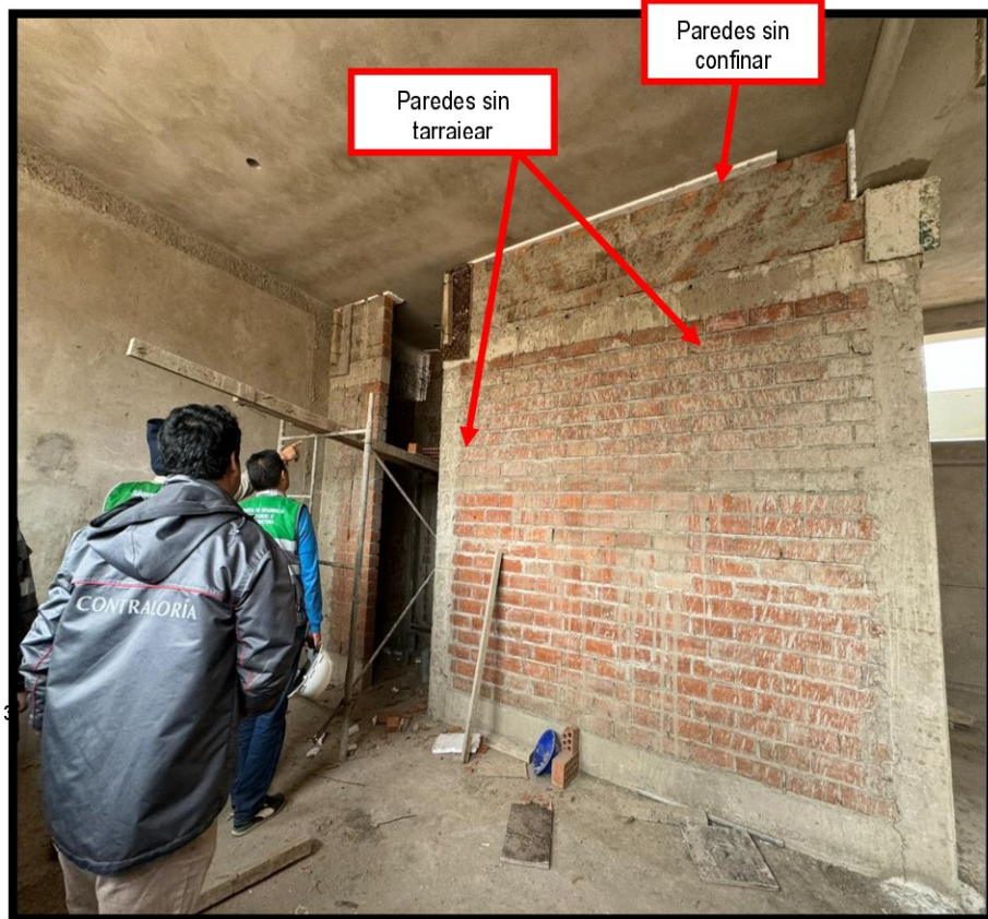
FOTOGRAFÍA N° 9 ESTADO DE LA SALA DE REUNIONES DEL MÓDULO VI DURANTE LA VISITA REALIZADA POR LA COMISIÓN DE CONTROL EL 15 DE AGOSTO DE 2024
