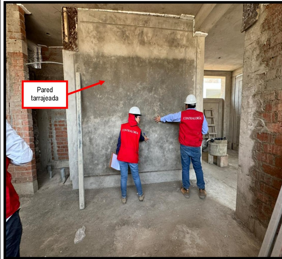
FOTOGRAFÍA N° 10 ESTADO DE LA SALA DE REUNIONES DEL MÓDULO VI DURANTE LA VISITA REALIZADA POR LA COMISIÓN DE CONTROL EL 11 DE AGOSTO DE 2024
