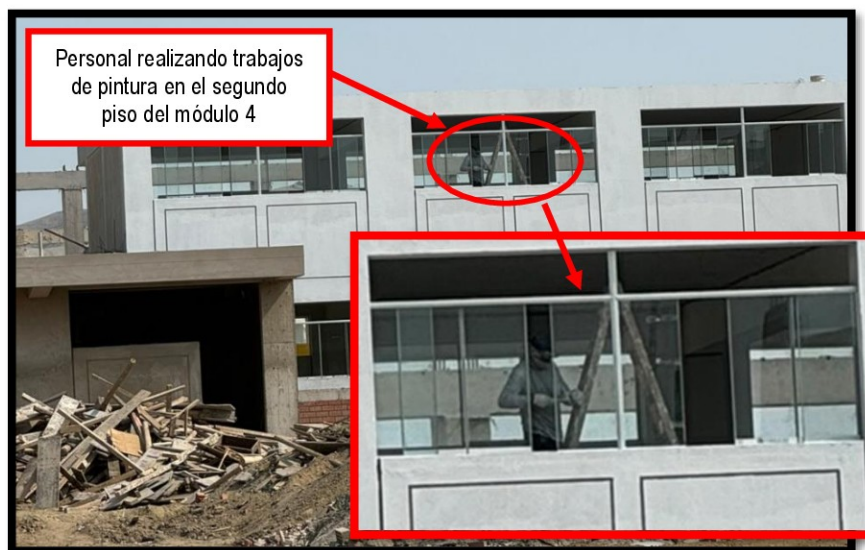
FOTOGRAFÍA N° 1 PERSONAL REALIZANDO TRABAJOS DE PINTURA EN SEGUNDO PISO DE MÓDULO 4
