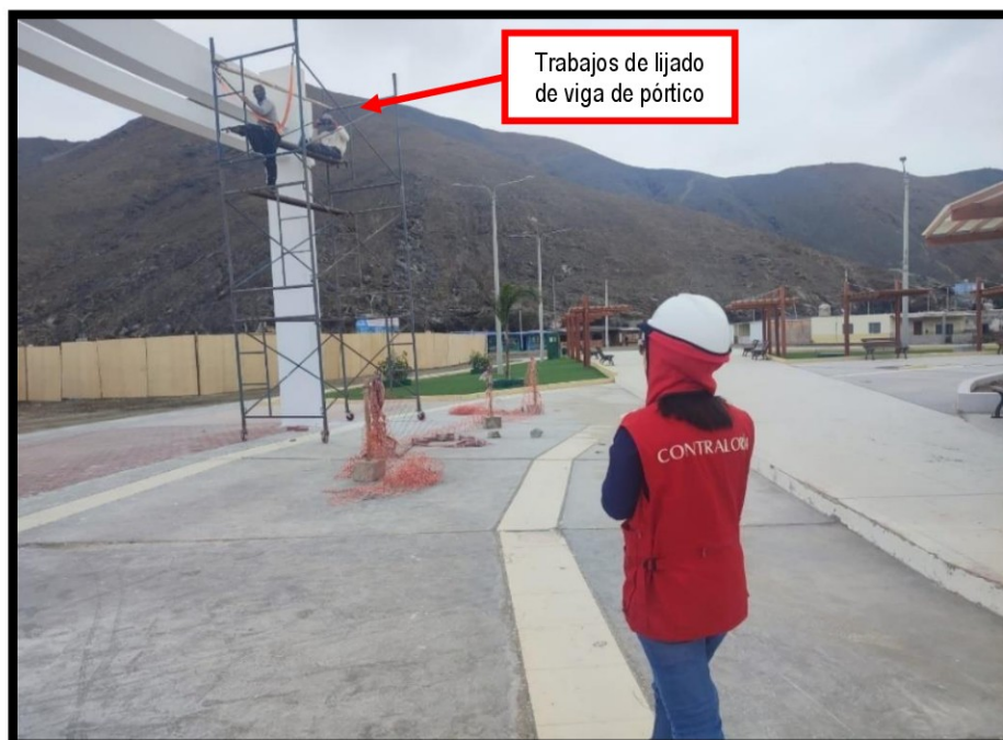
IMAGEN N° 1 LIJADO EN VIGA DE PÓRTICO
