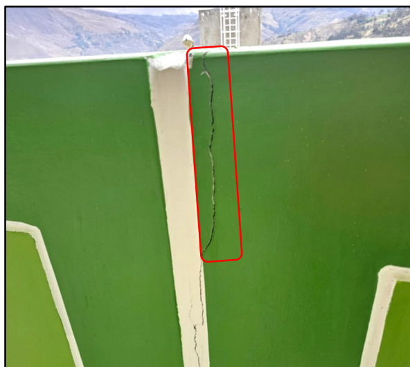
Fotografía n.º 7 Parapeto con fisura en el segundo nivel del bloque 1
