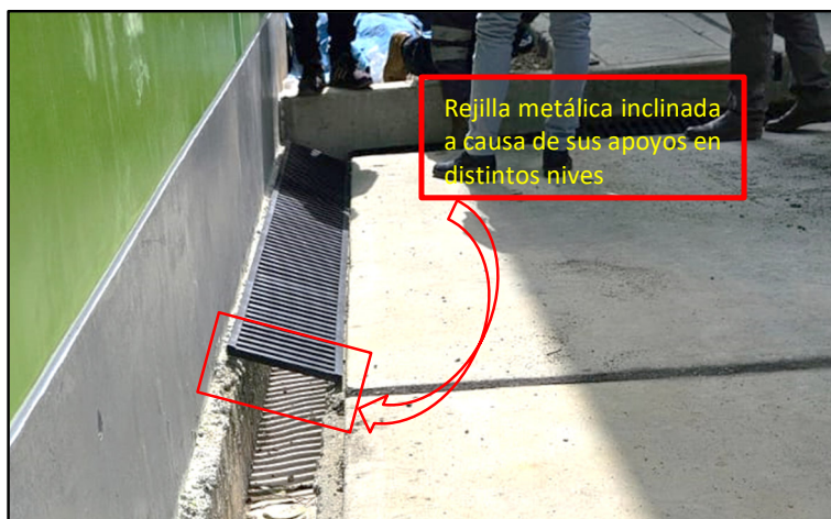
Fotografía n.º 4 Rejilla metálica con apoyos desnivelados
