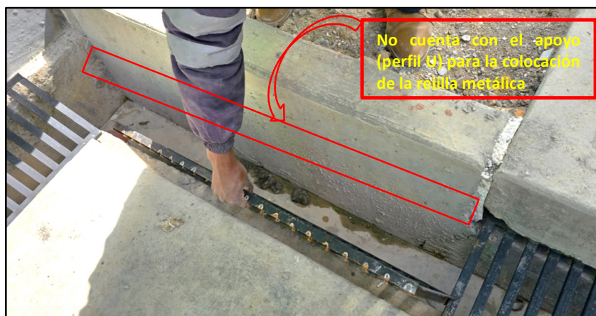
Fotografía n.º 3 Rejilla metálica sin apoyo
