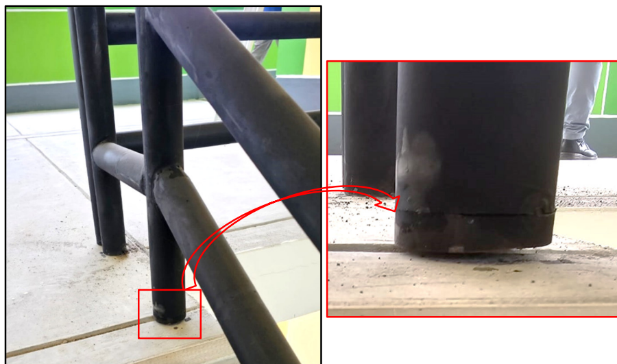
Fotografía n.º 5 Baranda de escalera unido con parte de tubo y anclaje distinto a los planos
