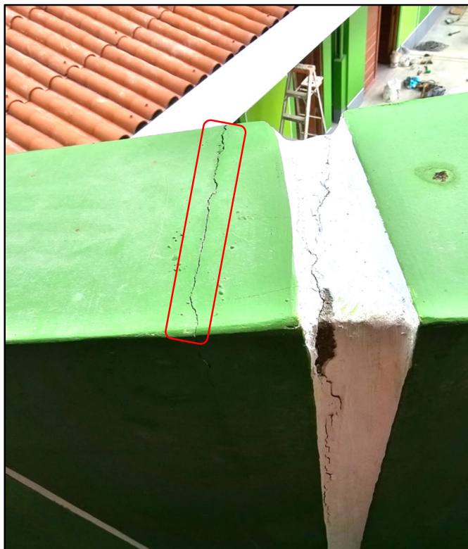
Fotografía n.º 8 Parapeto con fisura en el segundo nivel del bloque 2
