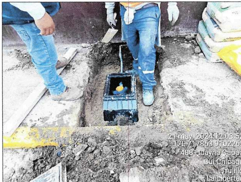
Fotografía n.º 12: Trabajos de instalación de medidor (intervención tipo A3) ubicado en Huayna Cápac N° 493 en la Urb. Santa María del distrito de Trujillo.
