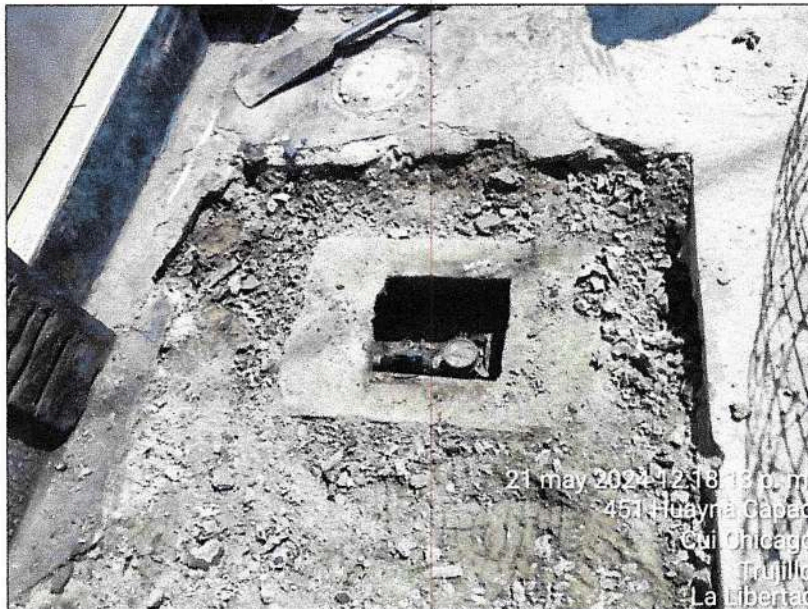
Fotografía n.º 22: Trabajos de instalación de medidor (intervención tipo A2) ubicado en Huayna Cápac N° 424 en la Urb. Santa María del distrito de Trujillo. Aún no se retira el medidor antiguo.
