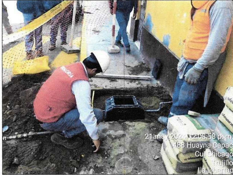
Fotografía n.º 13: Trabajos de instalación de medidor (intervención tipo A3) ubicado en Huayna Cápac N° 493 en la Urb. Santa María del distrito de Trujillo. Se tomó medidas al área de corte de vereda.
