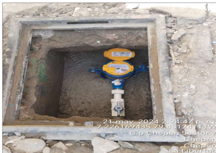
Fuente: Acta de inspección física n.º 03-2024-Hito de Control n.º 3 de 21 de mayo de 2024 Elaborado por: Comisión de control
