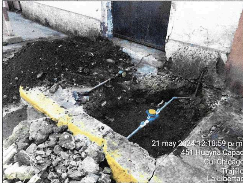
Fotografía n.º 15: Trabajos de instalación de medidor (intervención tipo A3) ubicado en Huayna Cápac N° 451 en la Urb. Santa María del distrito de Trujillo.
