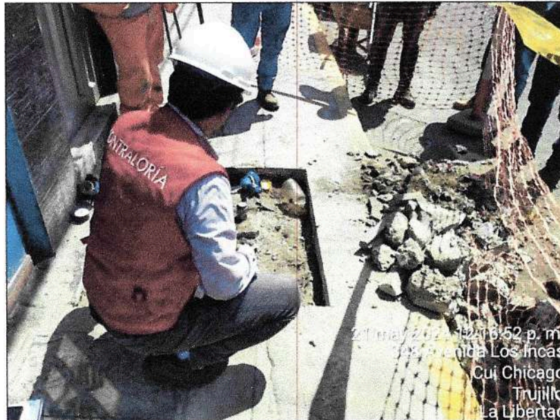
Fotografía n.º 18: Trabajos de instalación de medidor (intervención tipo A2) ubicado en Huayna Cápac N° 466 en la Urb. Santa María del distrito de Trujillo.
