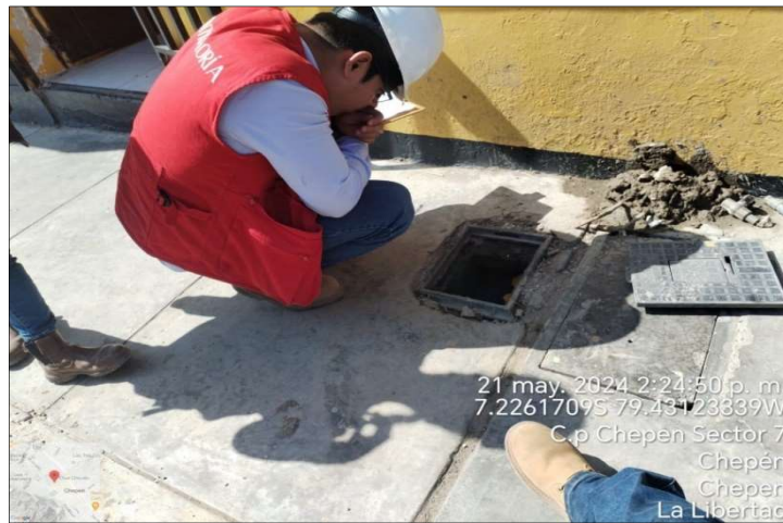
Fuente: Acta de inspección física n.º 03-2024-Hito de Control n.º 3 de 21 de mayo de 2024 Elaborado por: Comisión de control
