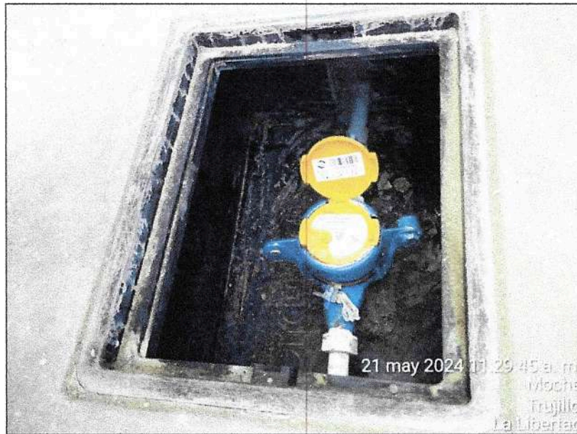
Fotografía n.º 10: Instalación de caja, marco y tapa termoplásticas (intervención tipo A3) en Sector Taquila Mz. 03 Lote 04 de la Calle Independencia del distrito de Moche.
