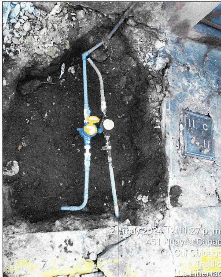
Fotografía n.º 16: Trabajos de instalación de medidor (intervención tipo A3) ubicado en Huayna Cápac N° 451 en la Urb. Santa María del distrito de Trujillo.
