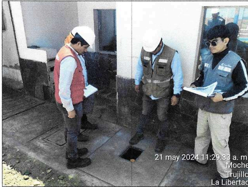
Fotografía n.º 9: Se inspeccionó el medidor ya instalado; fue una intervención tipo A2 por Renovación; ubicado Sector Taquila Mz. 03 Lote 04 de la Calle Independencia del distrito de Moche.
