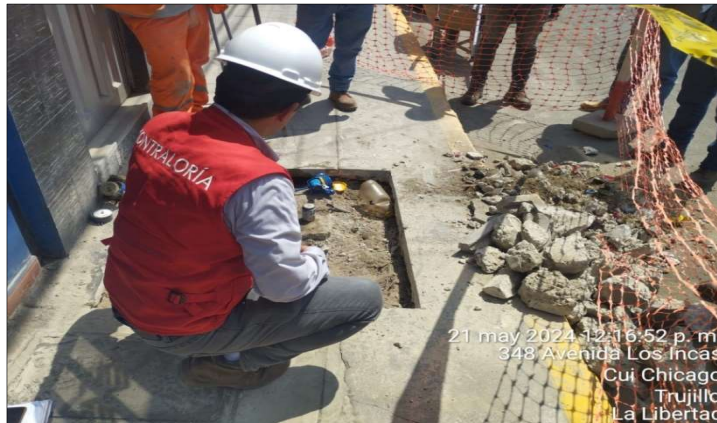
Fuente: Acta de inspección física n.º 02-2024-Hito de Control n.º 3 de 21 de mayo de 2024 Elaborado por: Comisión de control
