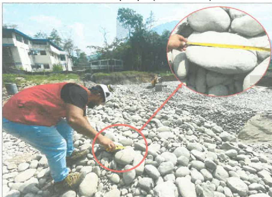
Fotografía n.º 5 Dimensiones del material pedraplén (adicional de obra)
