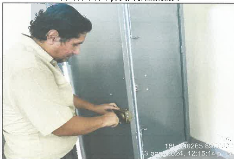
Panel fotográfico n.º 4 Cerradura de la puerta del ambiente 1
