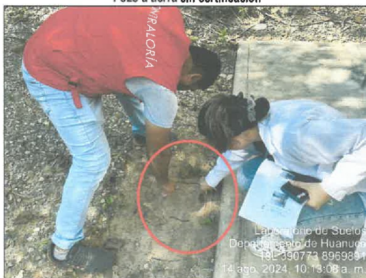
Panel fotográfico n.º 25 Pozo a tierra sin certificación
