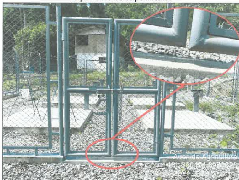
Panel fotográfico n.º 3 La puerta del cerco perimétrico
