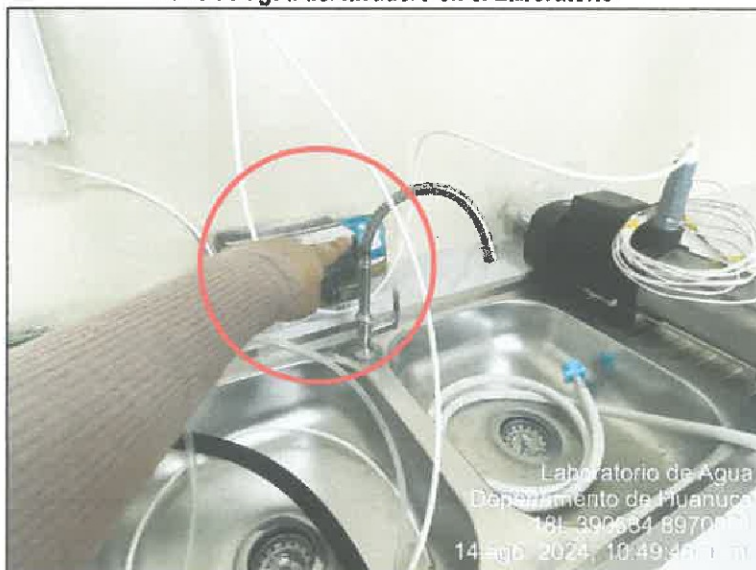
Panel fotográfico n.º 15 Llave de agua del lavadero en el Laboratorio
