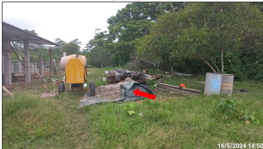
Fotografía n.º 389: Se observa el trompo mezclador de concreto y agregado almacenado.
