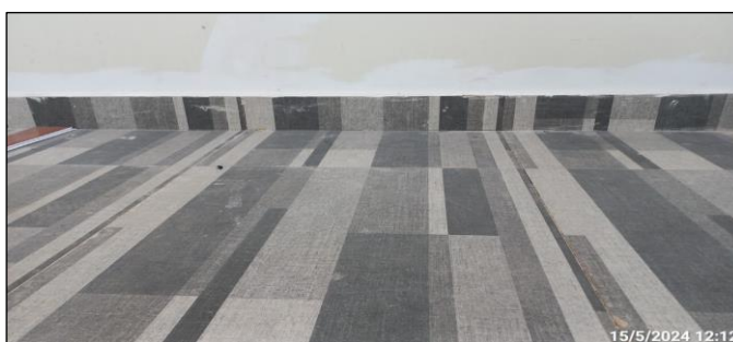
Fotografía n.ºs 148, 149 y 150: Se observa el piso y contrazócalos enchapados con porcelanato, sin fraguar.
