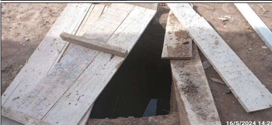
Fotografía n.ºs 243 y 244: Se observa una zanja detrás del módulo.
