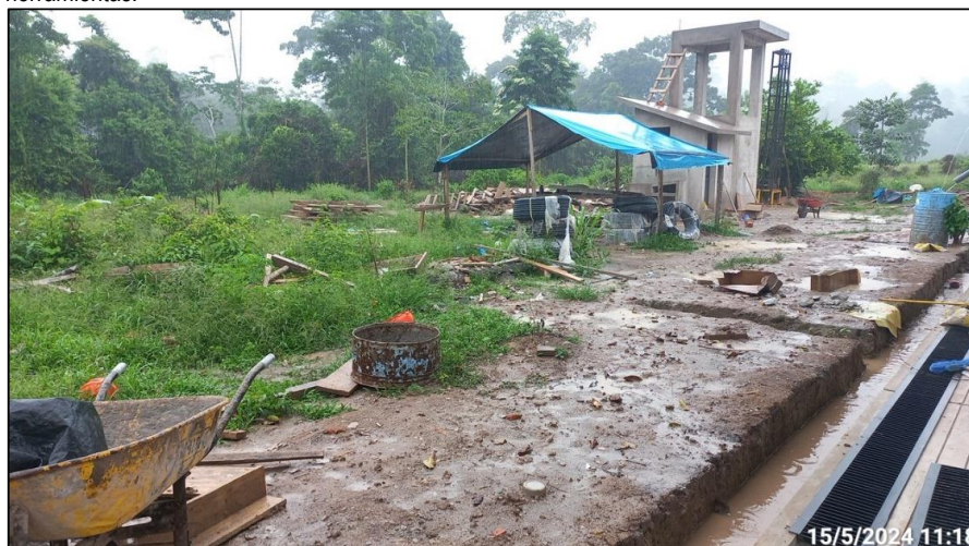
Fotografía n.º 403: Se observa otro ambiente al costado de la cisterna, construido con postes de madera y plásticos, en el cual se tiene rollos de mangueras.
