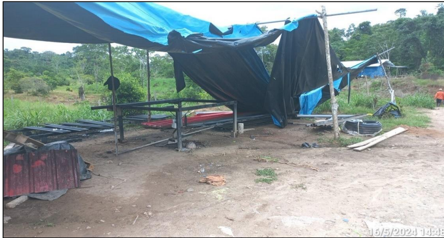
Fotografía n.º 398 y 399: Se observa otro ambiente, construido con postes de madera y plásticos, en el cual el 15/05/2024 se derrumbó por la precipitación pluvial. También se tiene rollos de manguera, rejillas metálicas, planchas de Aluzinc, tubos de PVC, perfiles metálicos.
