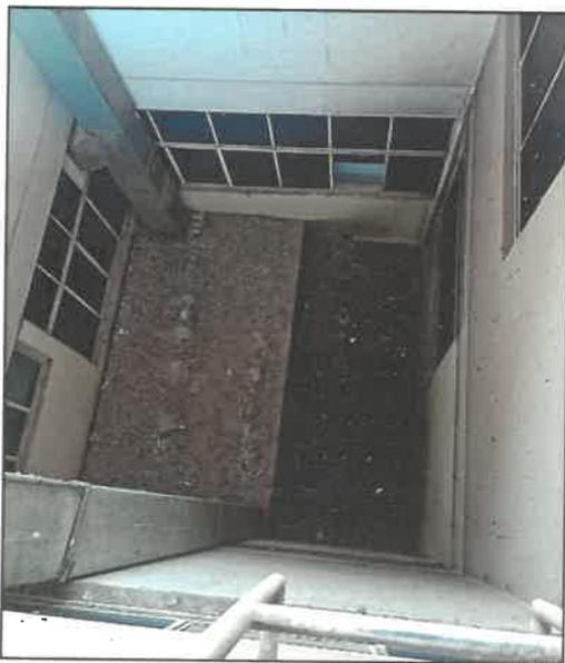
**Imagen n.º 17:** Heces y plumas de palomas en la cubierta del segundo nivel por donde sobresalen los conductos de humo de la cocina del Comedor Universitario.
