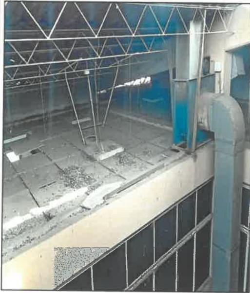
**Imagen n.º 15:** Plumas y heces de palomas en la parte externa de las baldosas del segundo nivel.
