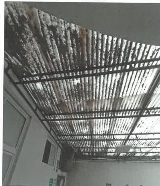
**Imagen n.º 10:** Techo y calaminas en mal estado y sucios en el área del lavadero del Comedor Universitario.
