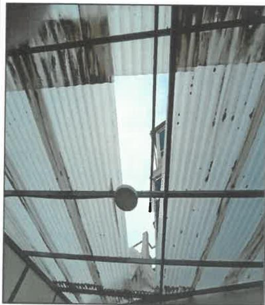
**Imagen n.º 9:** Calaminas en mal estado y rotos del área del lavadero del Comedor Universitario.
