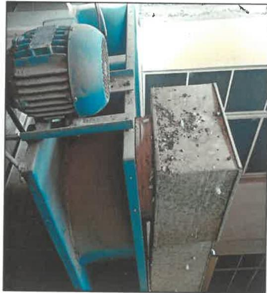
**Imagen n.º 16:** Motor del tanque de hidroneumático con heces y plumas de palomas.
