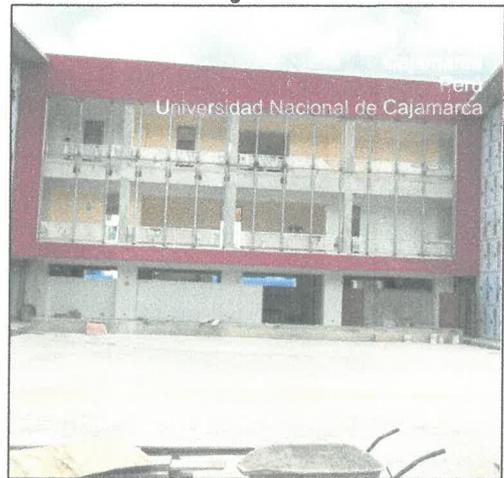
Vista frontal y posterior del módulo B, en donde se observa, con respecto al adicional N° 3, solamente la instalación de perfiles metálicos del muro cortina.
