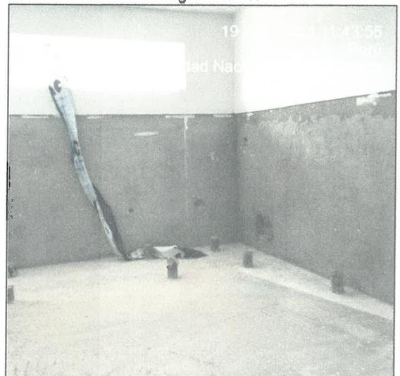
Estado situacional de los servicios higiénicos del tercer nivel del módulo C, en donde se observa que no se ha colocado el porcelanato en pisos y paredes, ni se han instalado los aparatos sanitarios.
