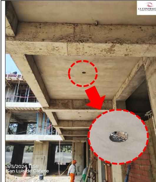
**Fotografía 1:** Salidas para alumbrado en techo, no cuentan con conductores eléctricos cableados
