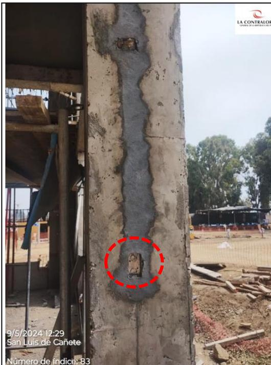
**Fotografía 3:** Salidas para interruptor, no cuentan con conductores eléctricos
