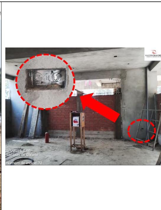
**Fotografía 4:** Salidas para tomacorrientes, no cuentan con conductores eléctricos
