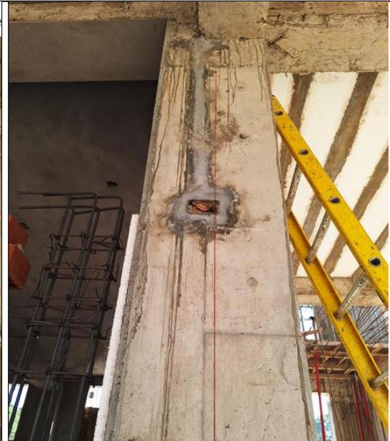
**Fotografía 2:** Salidas para alumbrado de emergencia, no cuentan con conductores eléctricos cableados
