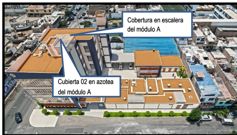
Imagen n.º 33 “02.04.02 Cobertura en escalera de módulo A” y “02.04.04. Cubierta 02 en azotea del módulo A”
