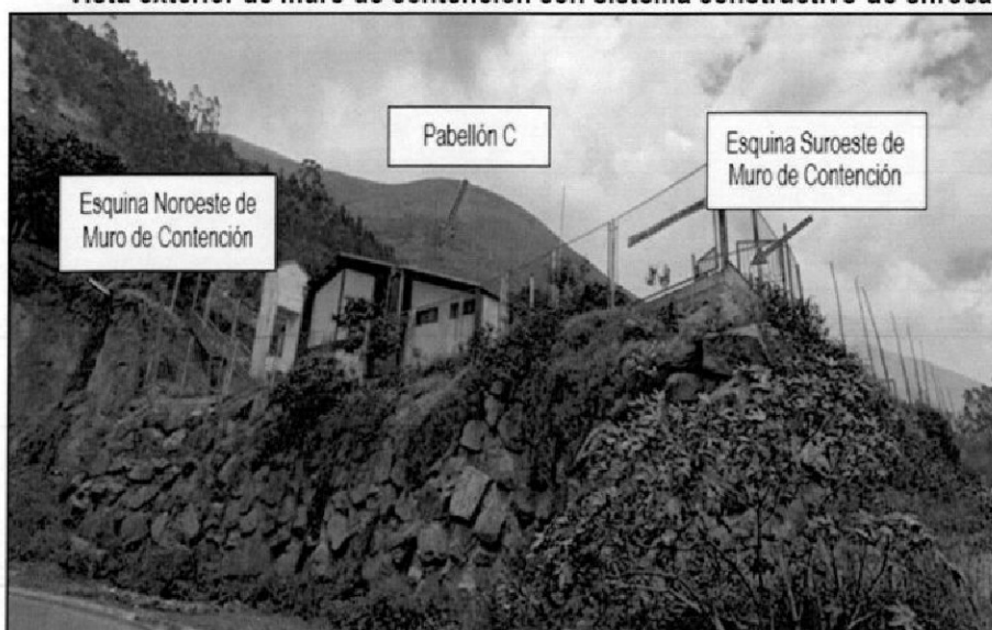
Imagen n.° 7 Vista exterior de muro de contención con sistema constructivo de enrocado
