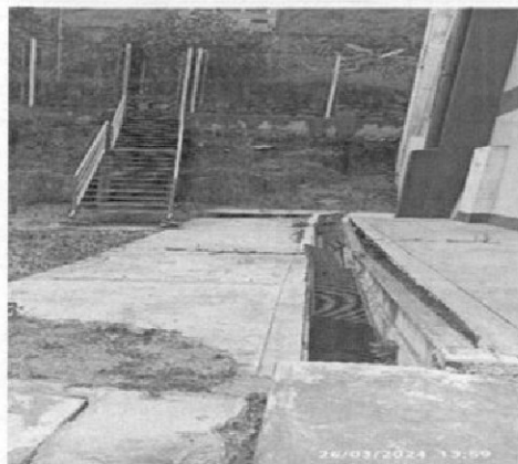
Imagen n.º 13 Deformaciones y agrietamientos del patio producto del asentamiento del terreno
