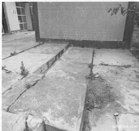
Imagen n.º 14 Deformaciones y agrietamientos del patio producto del asentamiento del terreno
