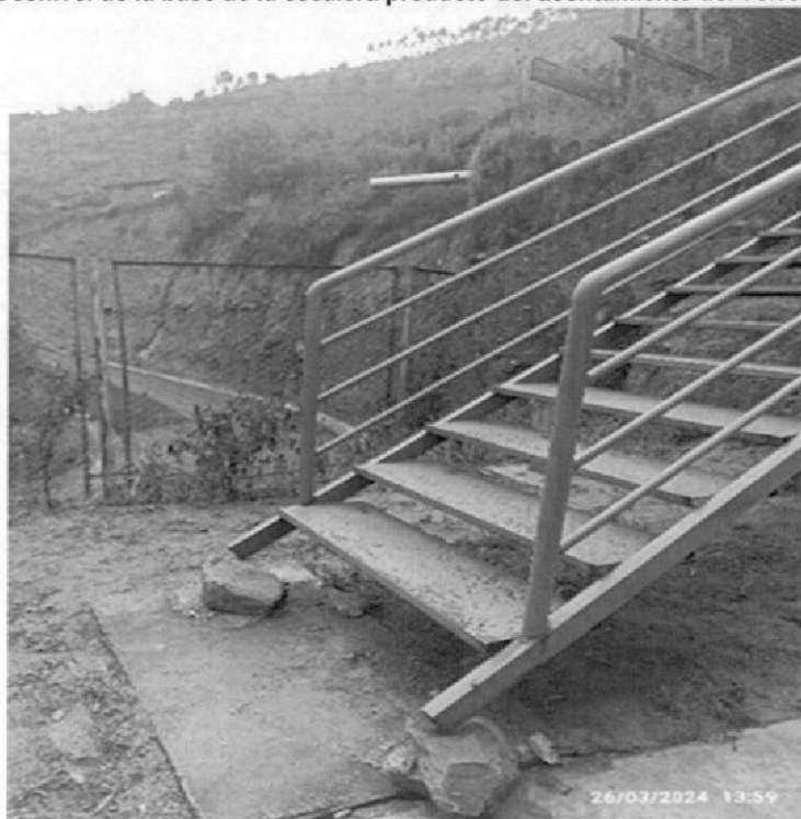
Imagen n.º 15 Desnivel de la base de la escalera producto del asentamiento del Terreno
