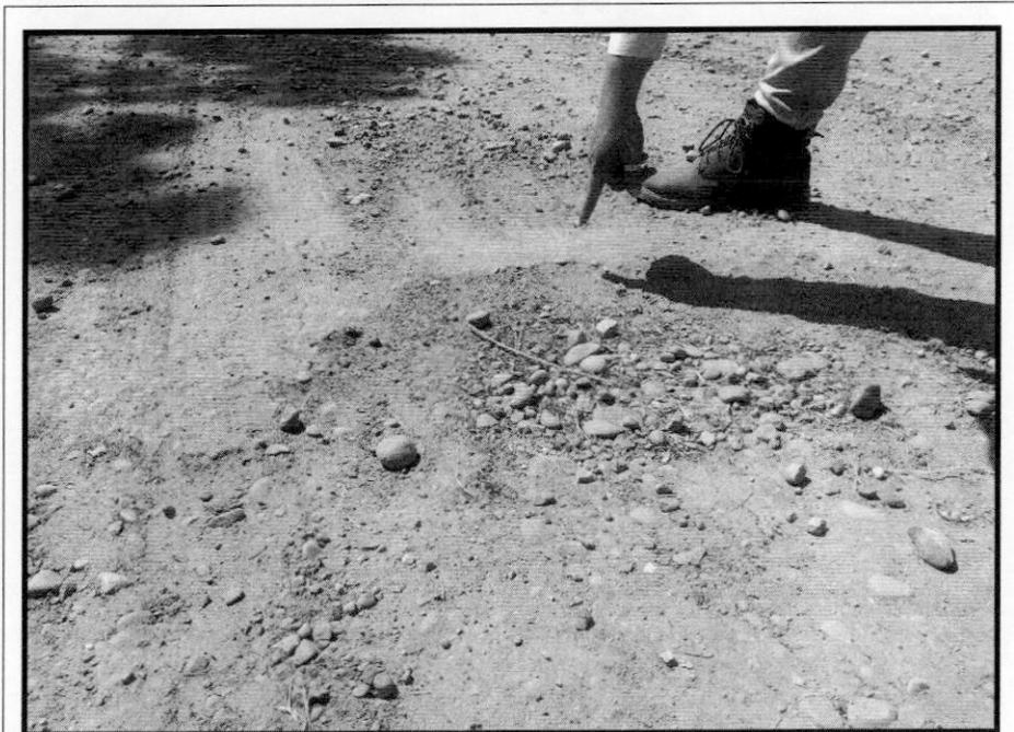
Km 1+600 - Disgregación de la base granular evidenciada
