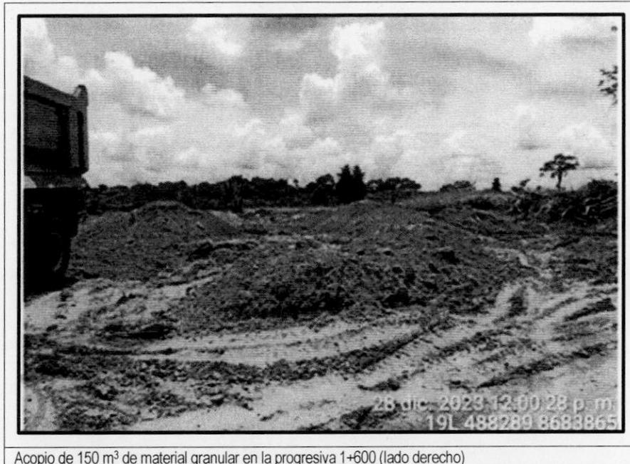
Acopio de 150 m<sup>3</sup> de material granular en la progresiva 1+600 (lado derecho)
